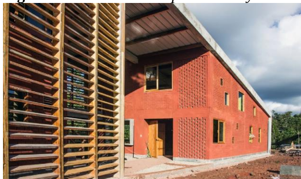
Figura 12. Detalle muro apersianado y ladrillos artesanales.
