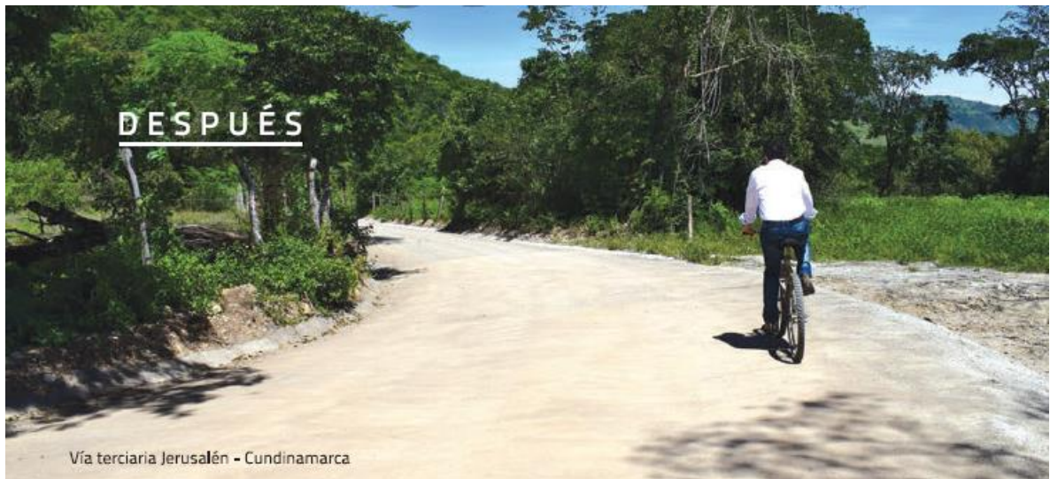
Figura 2. Caso de éxito cemento UG y aditivo solidificante
