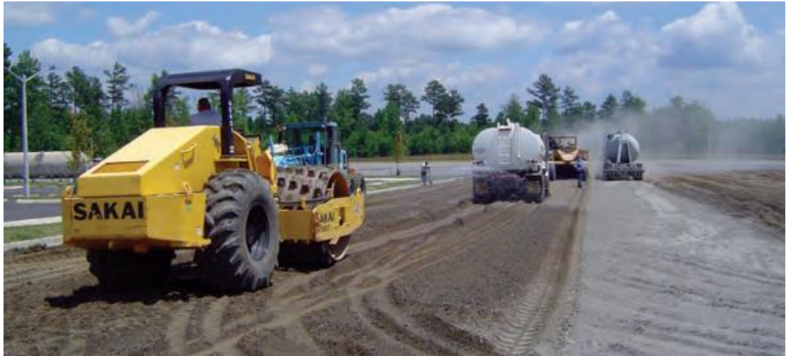
Figura 14. Suelo modificado con cemento, proceso constructivo.
