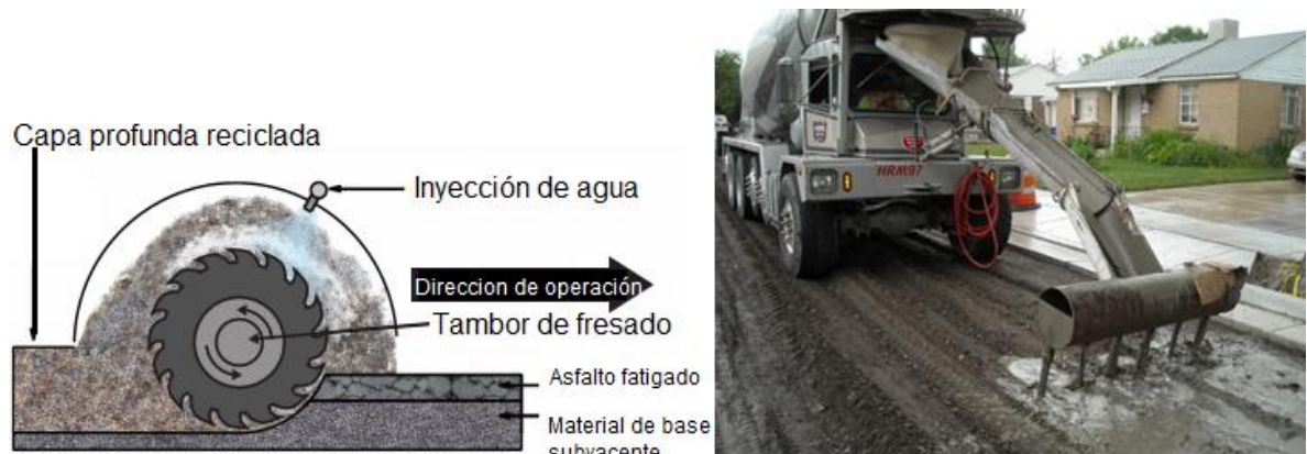
Figura 16. Esquema de recuperador de carreteras durante el proceso FDR
