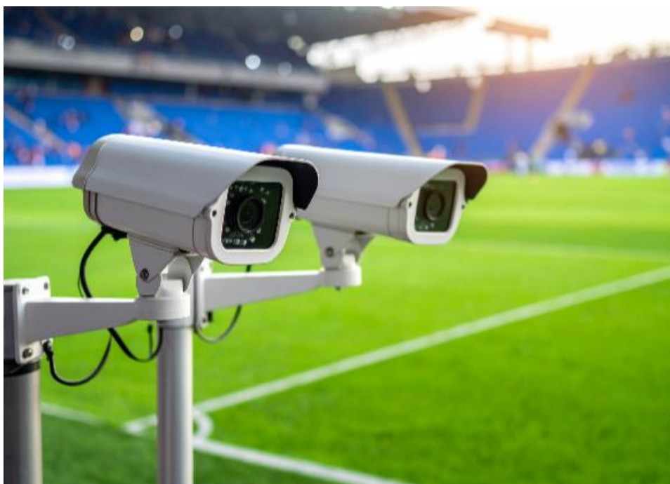
Imagen 22. Cámaras de seguridad
