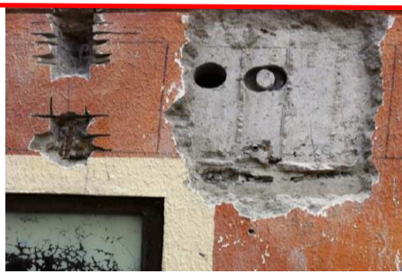
Debido a que no se cuenta con información directa sobre la resistencia de diseño y/o constructiva del concreto, se hizo necesario realizar extracción de núcleos normalizados de concreto.
