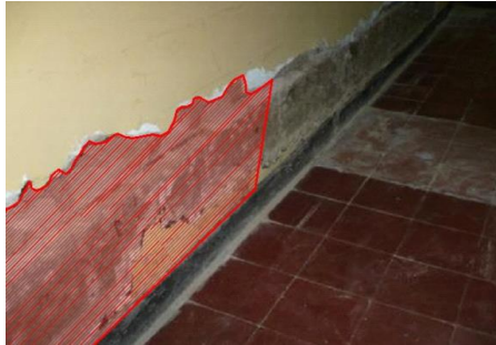
Elementos de mampostería inutilizados. Se observa presencia de humedades y desprendimientos en muros.
