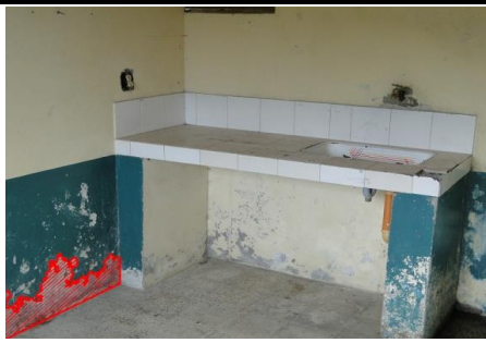
Elementos de mampostería inutilizados. Se observa presencia de humedades y desprendimientos en muros.
