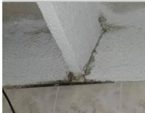
Imagen 30 - Reparación de corrosión oxidación. Fuente propia
