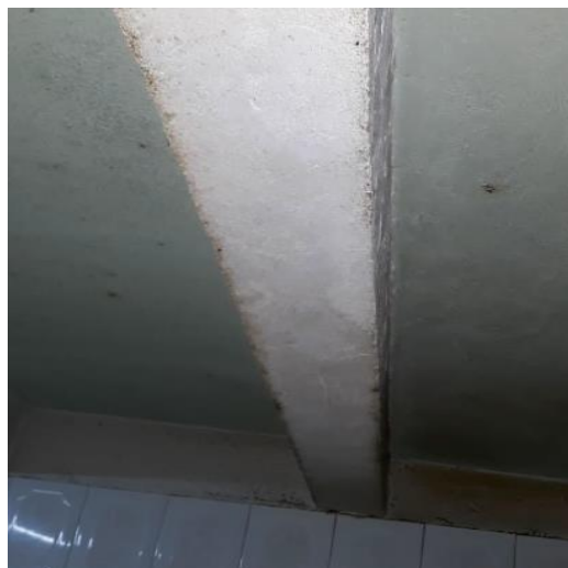
Imagen No 13 - Vigueta 0.10 m x0.25m . Fuente propia
