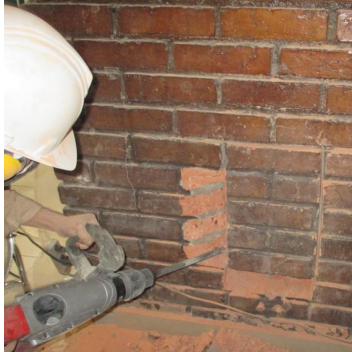
Imagen No 14 - Extracción de murete en mampostería, zona de patio. Fuente propia.
