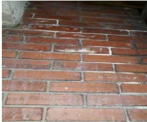
Imagen No 28 - Reparación de eflorescencias. Fuente propia
