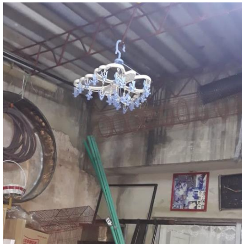
Imagen No 15 - Levantamiento de cubierta zona de patio, correas apoya una cubierta en teja ondulada. Fuente propia
