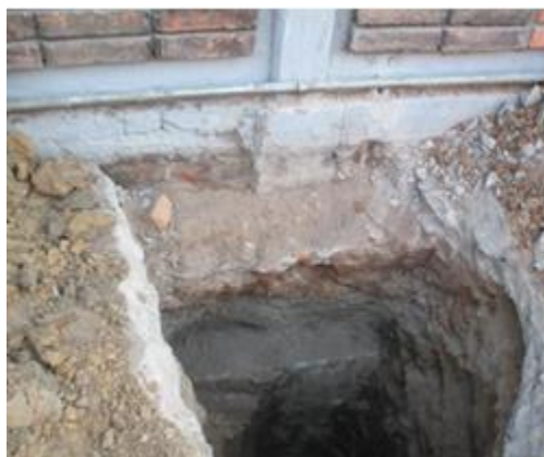
Imagen No 17 - Apique 1, muro de mampostería cimiento corrido, ciclópeo. Fuente propia
