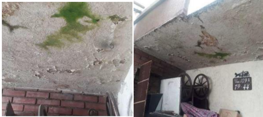
Imagen No 25 - Reparación de desprendimientos. Fuente propia
