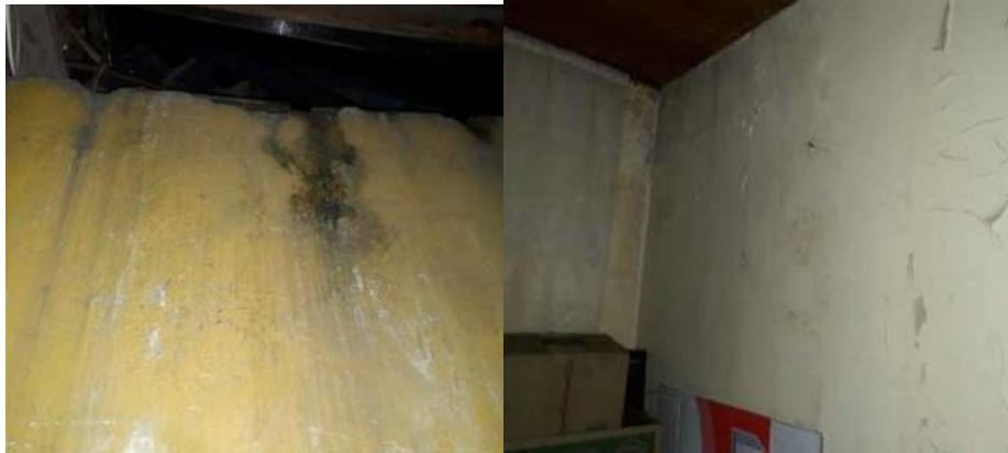
Imagen 28 - Reparación de filtración. Fuente propia
