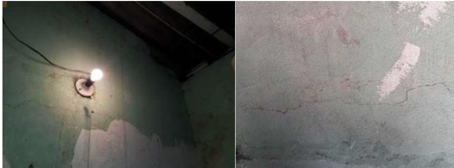
Imagen No 29 - Reparación de fisuras. Fuente propia
