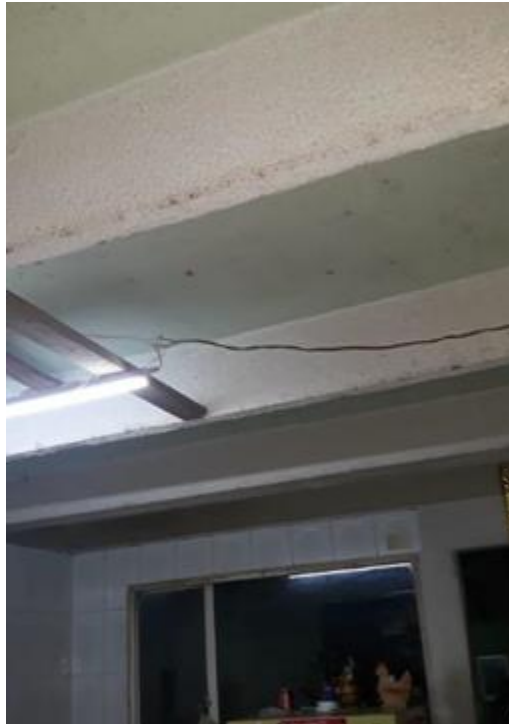
Imagen No 11 - Zona de localización para extracción de murete en mampostería. Fuente propia
