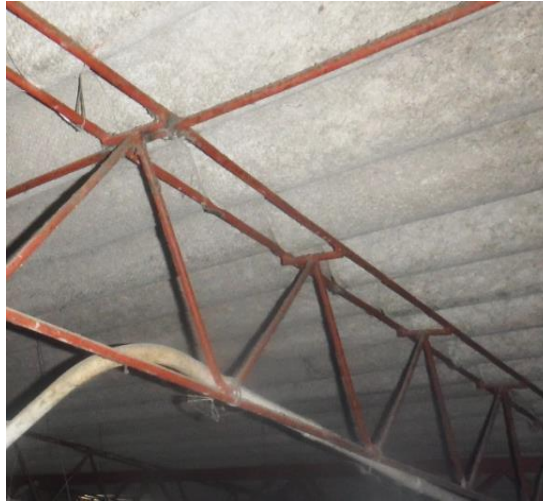
Imagen No 16 - Correa metálica diámetro 9.525 mm . Fuente propia
