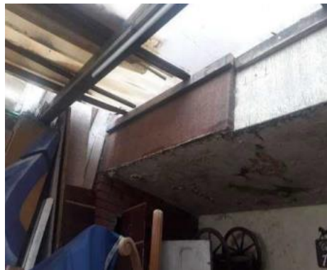
Imagen 27 - Reparación de humedades. Fuente propia
