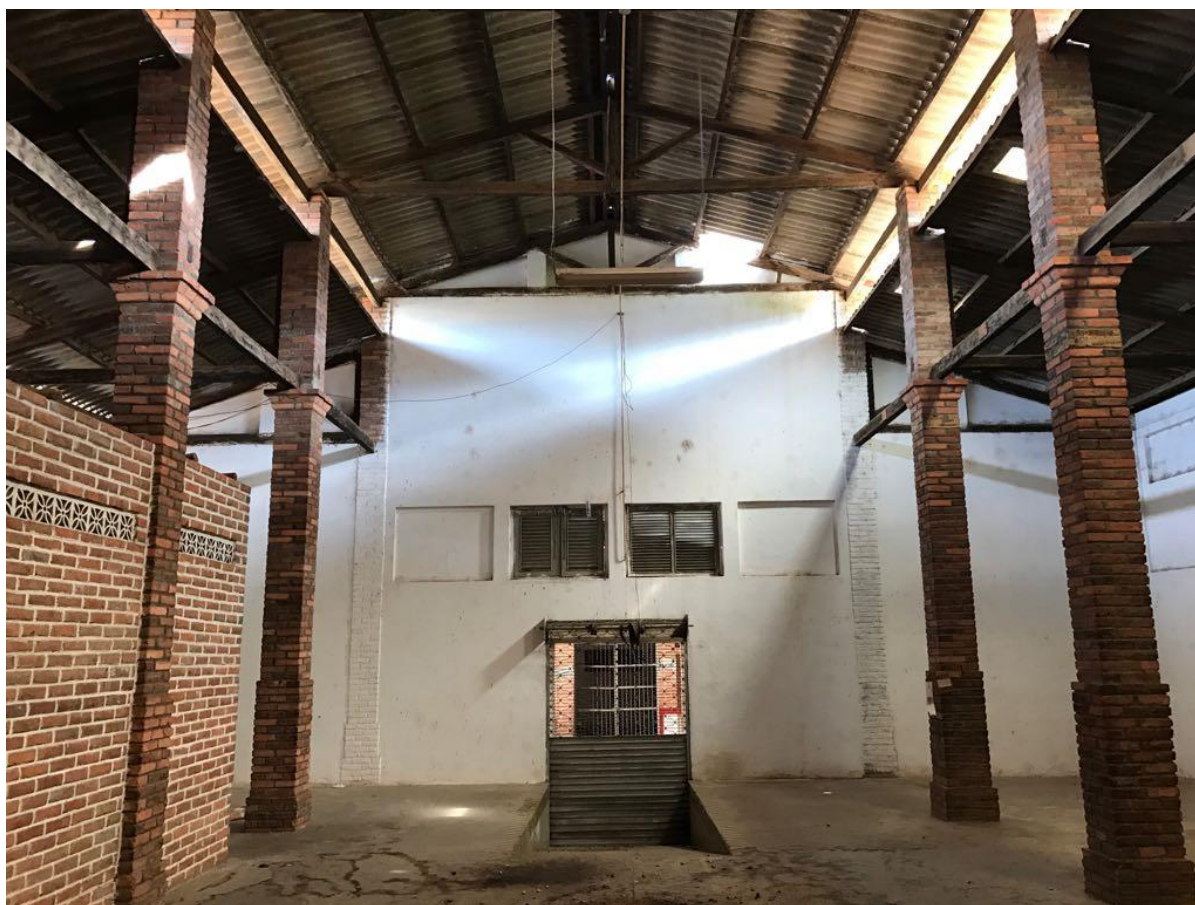
Figura 14. Estructura interna de la construcción
