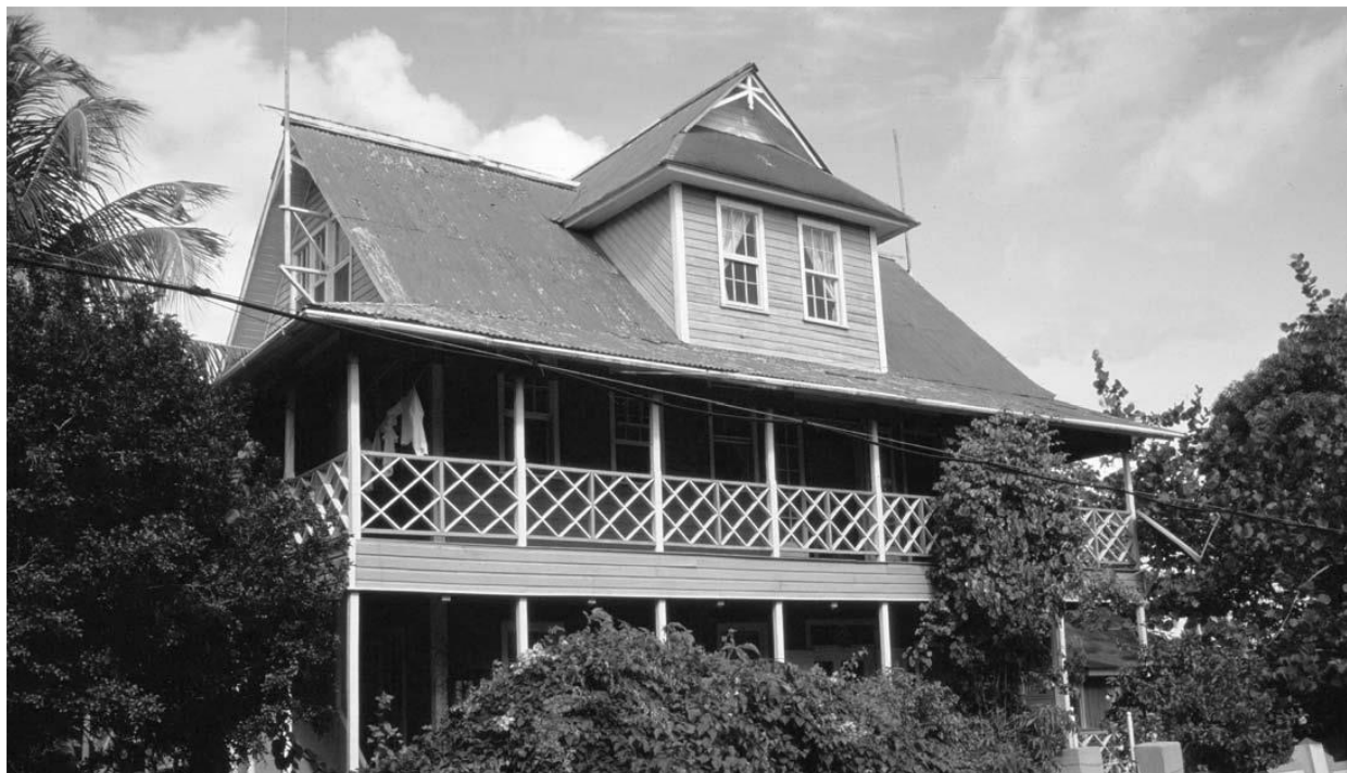
Vivienda. San Andrés. Foto: Alberto Saldarriaga.
