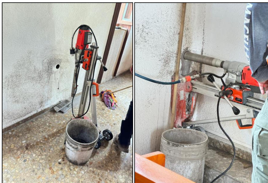
Ilustración 16. Extracción de núcleos
