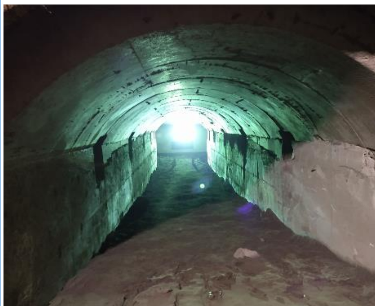
Vista desde aguas abajo (casa de máquinas)
