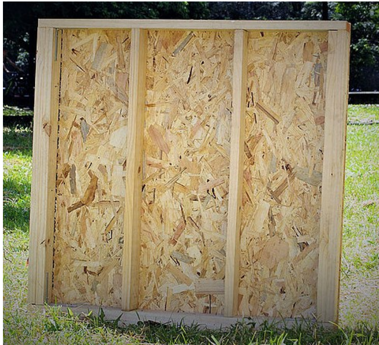
Figura 40. Lamina de muro elaborada con hojuelas de madera
