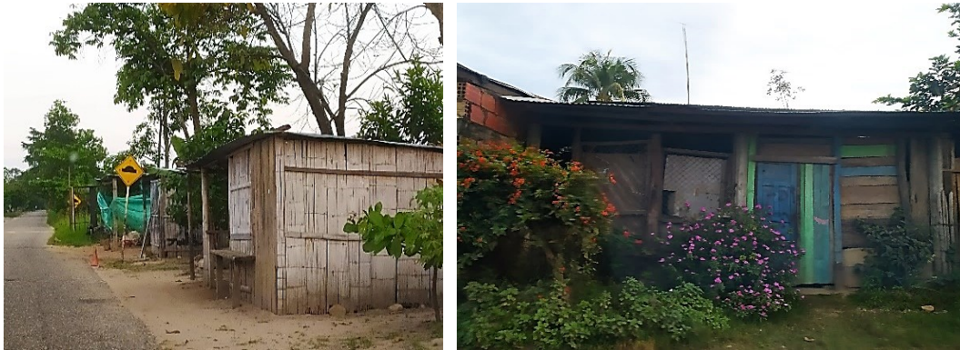
Figura 19. Estado actual de las viviendas en el sector de 4 esquinas.
