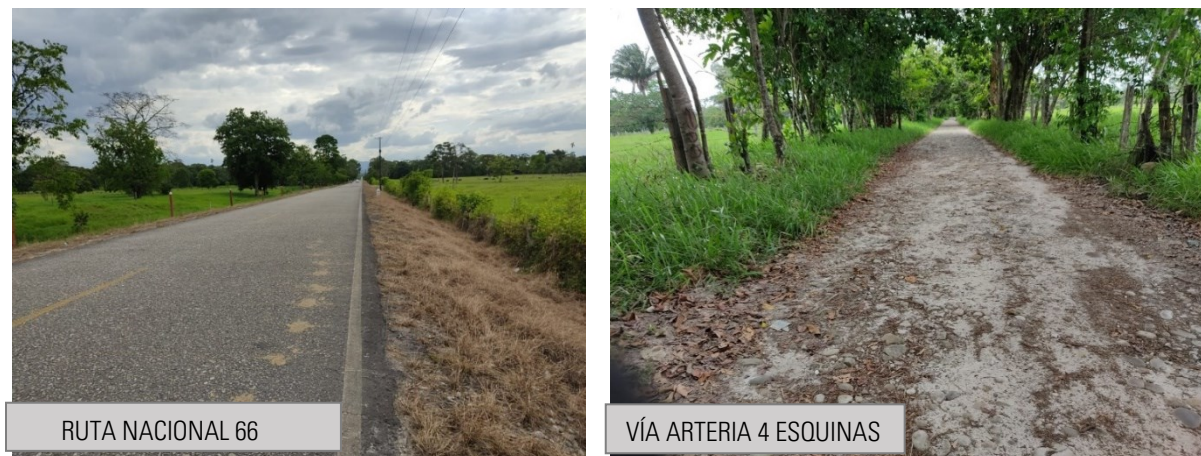
Figura 16. Estado actual de las vías concurrentes al predio
