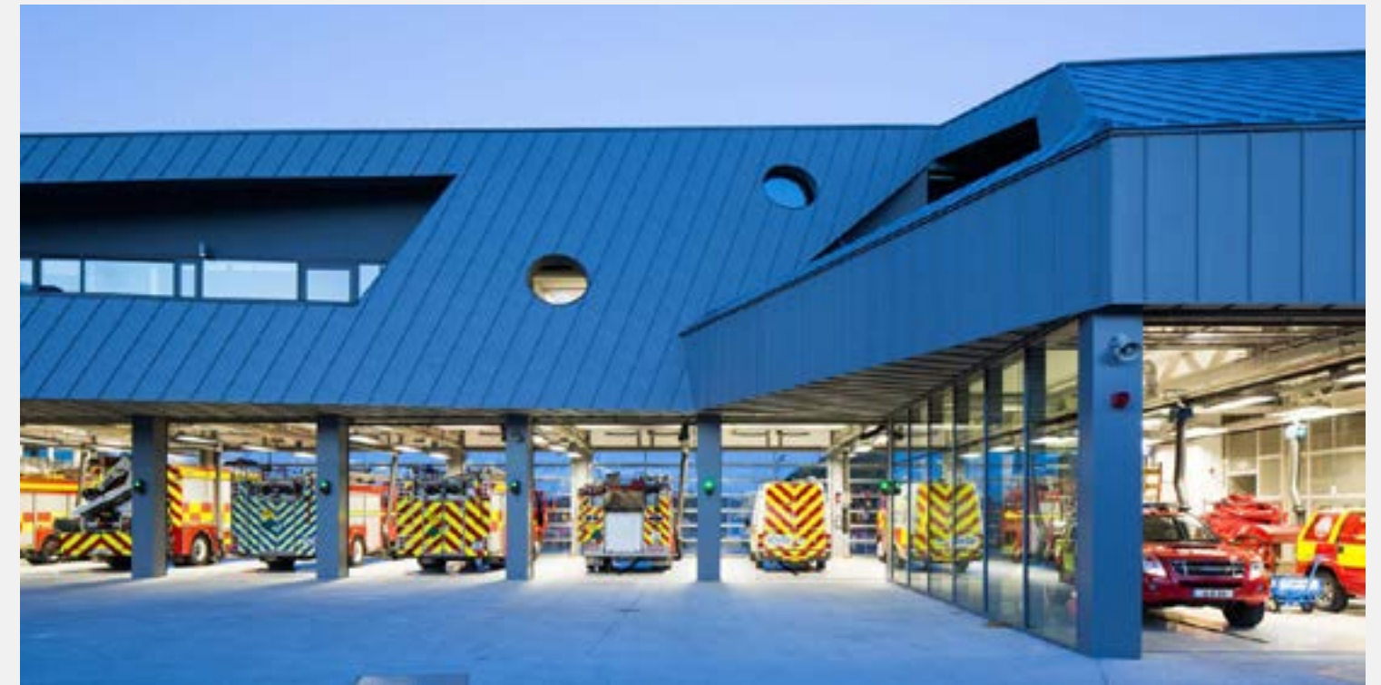
Figura 7. Estación de bomberos Waterford - McCullough Mulvin Architects - Imagen de archdaily
