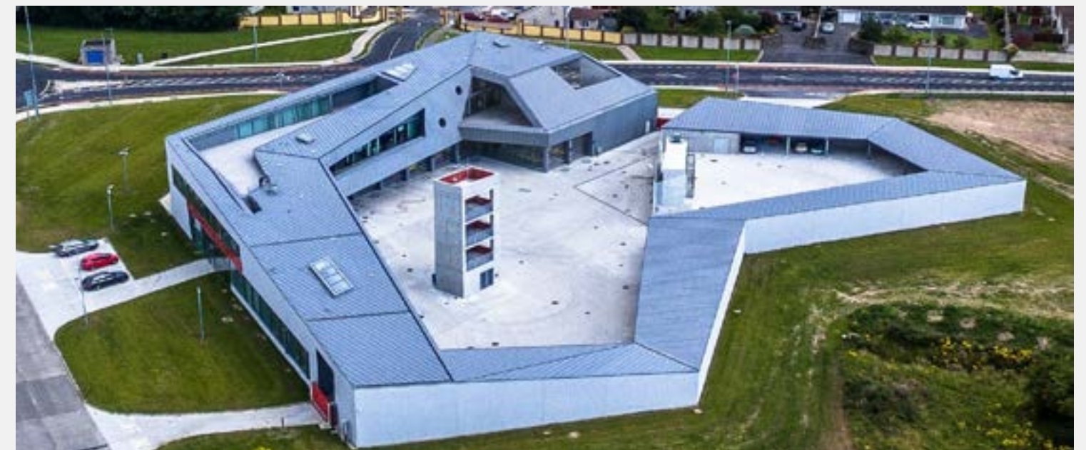
Figura 8. Estación de bomberos Waterford - McCullough Mulvin Architects - Imagen de archdaily
