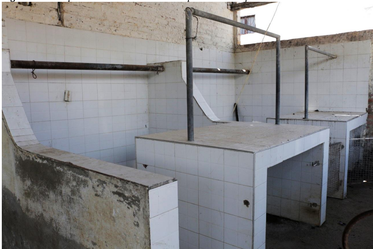
Figura 10. Vista parcial del estado actual de la planta de sacrificio
