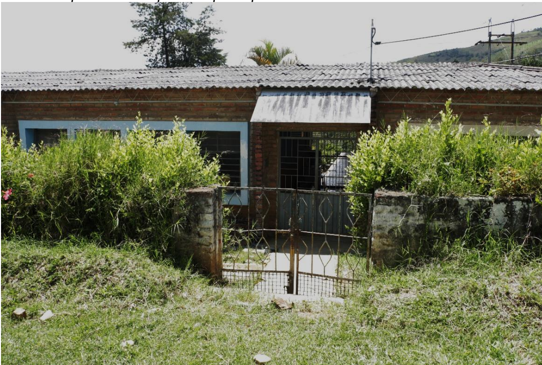
Figura 12. Vista parcial de la fachada principal de la escuela
