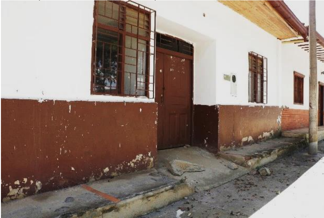
Figura 11. Vista parcial del estado actual del puesto de salud
