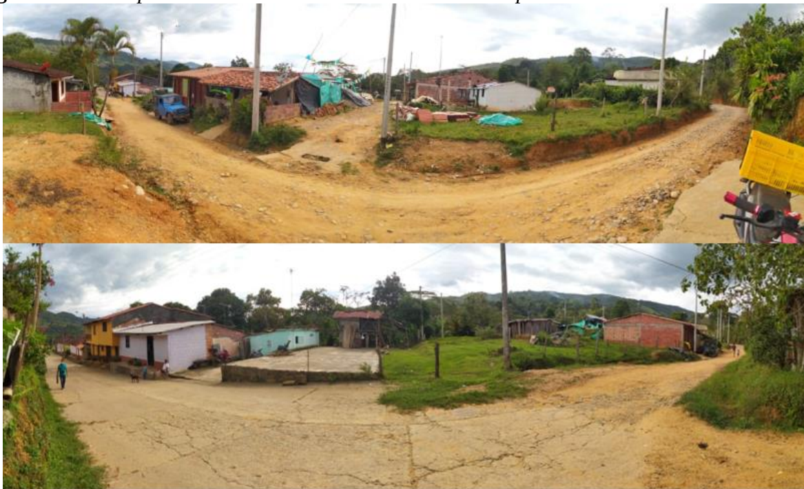
Figura 14. Vistas panorámicas de la vía de acceso al centro poblado Riachuelo
