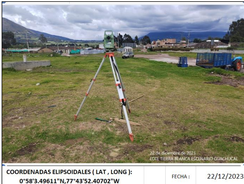
Figura 1. Fotografía Vista zona Norte del predio.
