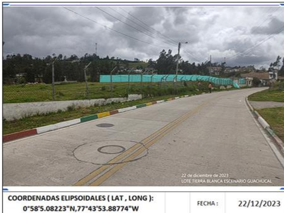
Figura 4. Vista vía costado oeste del predio
