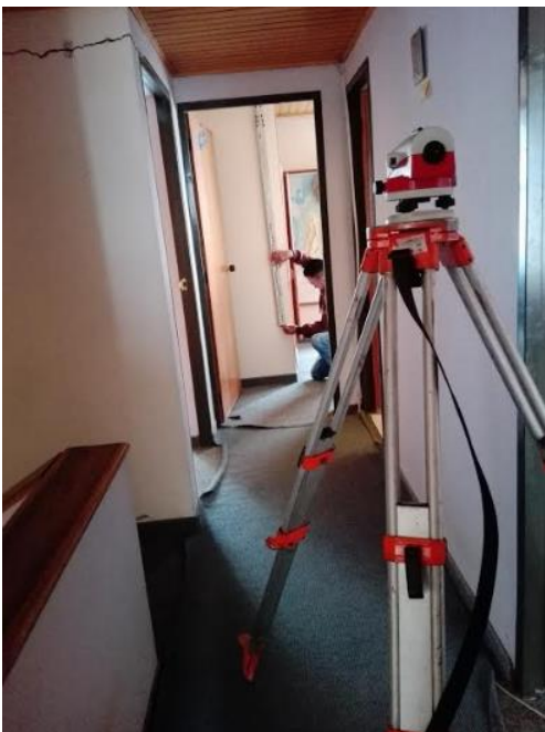
Fotografía 10: Toma de niveles bajo placa del Segundo piso. Fuente propia 2019
