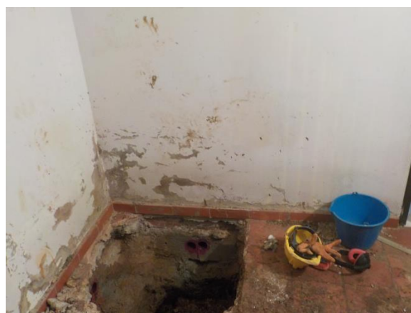
Fotografía 21 : Viga cimentación en concreto simple, profundidad 0.5m. Fuente propia 2017.
