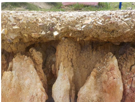
Fotografía 4: Detalle de fotografías 2 y 3 suelo erodable con presencia de cárcavas. Fuente propia 2017.
