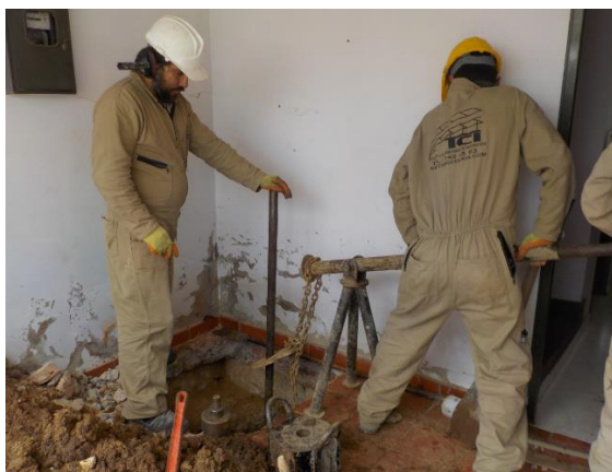
Fotografía 11 : Apique1 mostrado en la fotografía 9.
