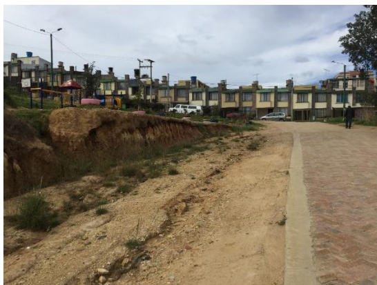
Fotografía 2: Vista general del barrio, se observa alrededores con suelos erosionables. Fuente propia 2017.
