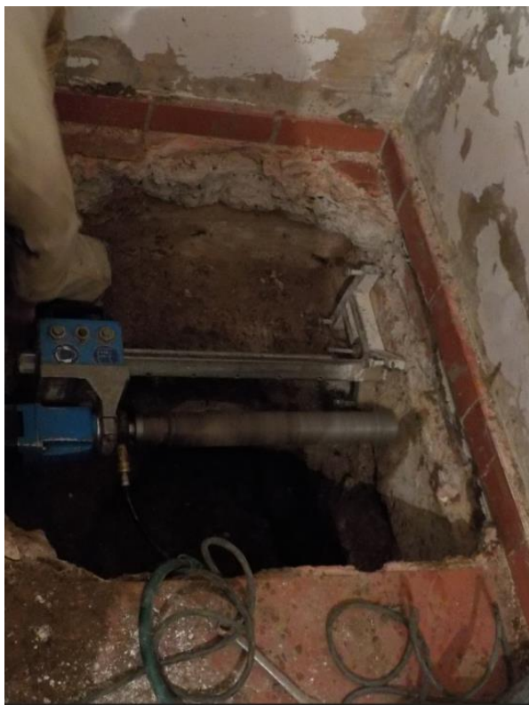
Fotografía 9 : Extracción de núcleo en viga de cimentación explorada en el apique 1. Fuente propia 2017.
