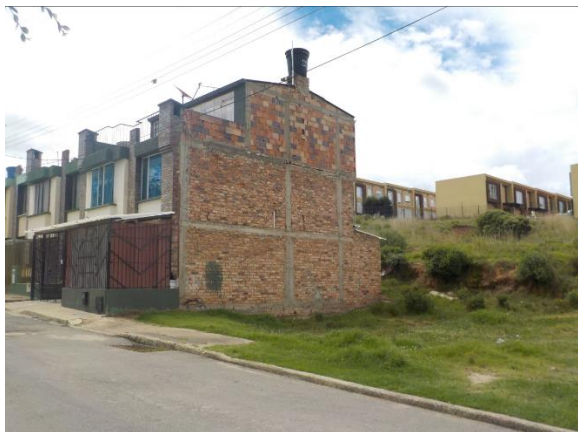
Fotografía 24: Vista general de la urbanización Palos verdes, se observa muros de mampostería en ladrillo macizo. Fuente propia 2017.
