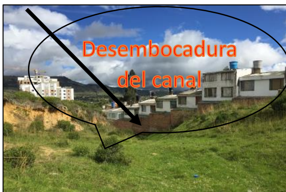
Fotografía 6: Desembocadura del canal contra las viviendas. Fuente propia 2017.
