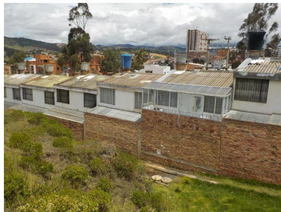
Fotografía 25: Vista de la Urbanización al respaldo de la misma, se observa mampostería en ladrillo macizo. Fuente propia 2017.
