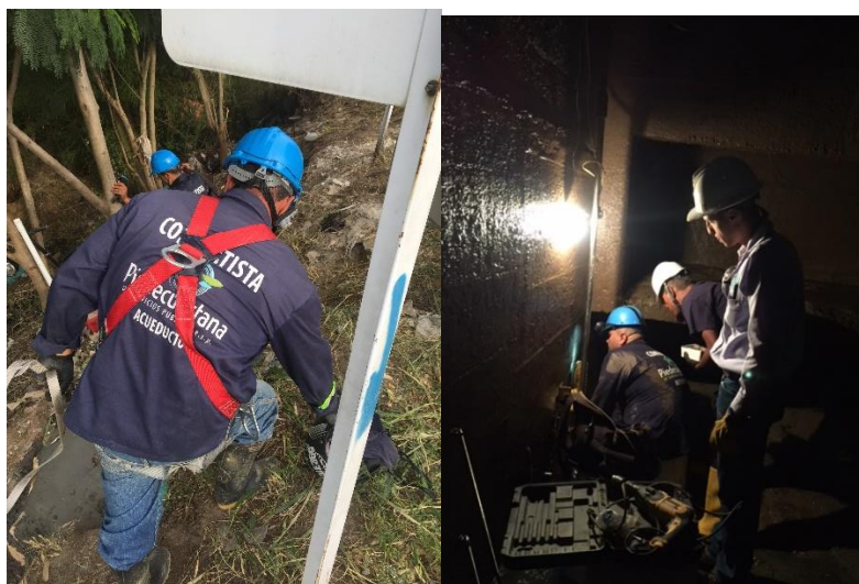
Figura 2 Acompañamiento en obras
