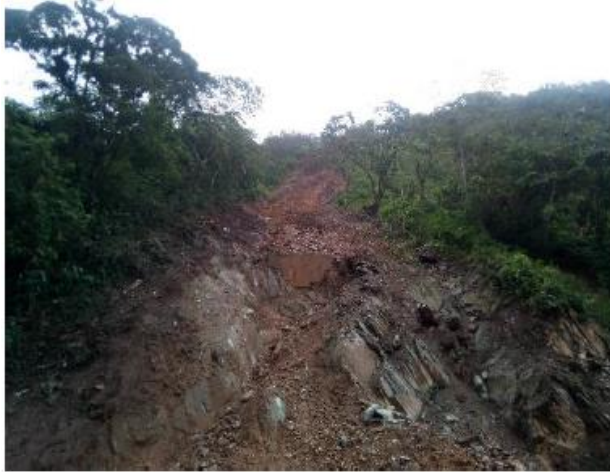
Figura 18. Procesos de remoción en masa y caída de detritos a la vía existente desde la ladera suroccidental de Mesa Grande. Izquierda
