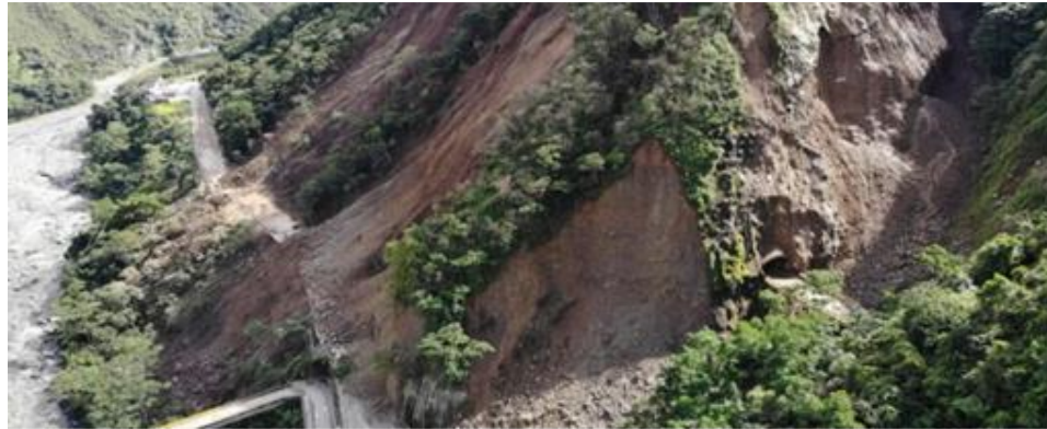
Figura 2. Derrumbe Kilómetro 58, Municipio de Guayabetal
