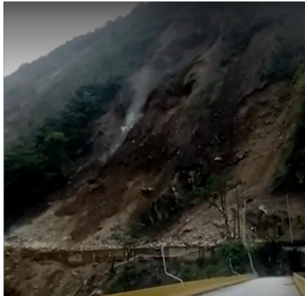
Figura 45. Desprendiendo de material 11 de junio 2019
