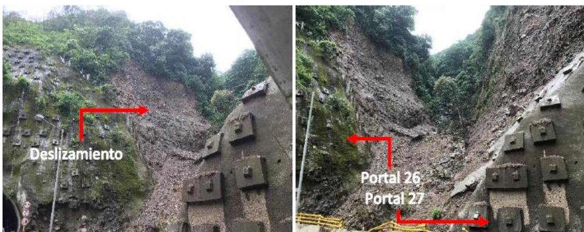
Figura 31. Deslizamiento portal 26 y 27
