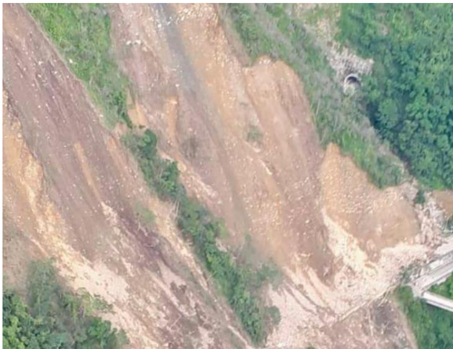
Figura 47. Colapso del puente Quebrada seca
