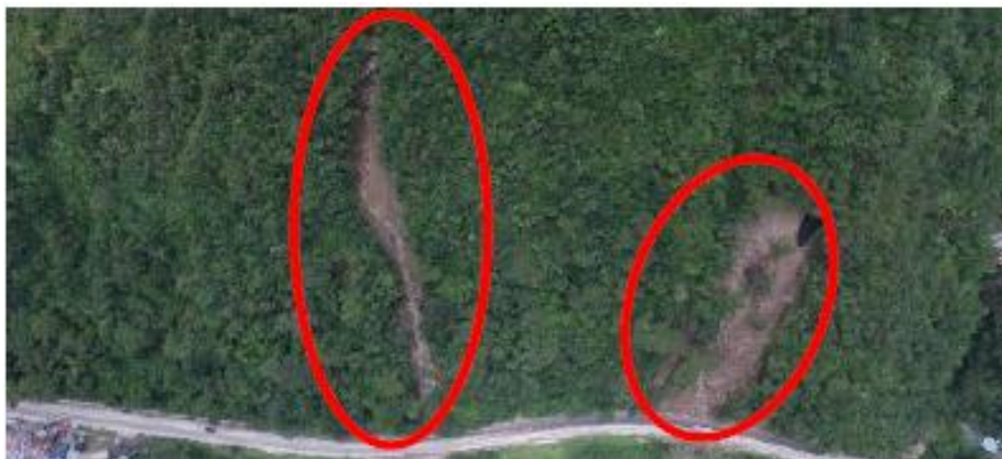
Figura 29. Flujo de detritos que afecta la vía
