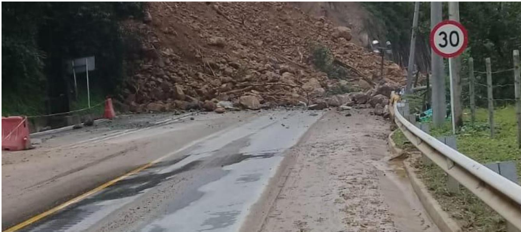
Figura 43. Derrumbe y taponamiento de la vía
