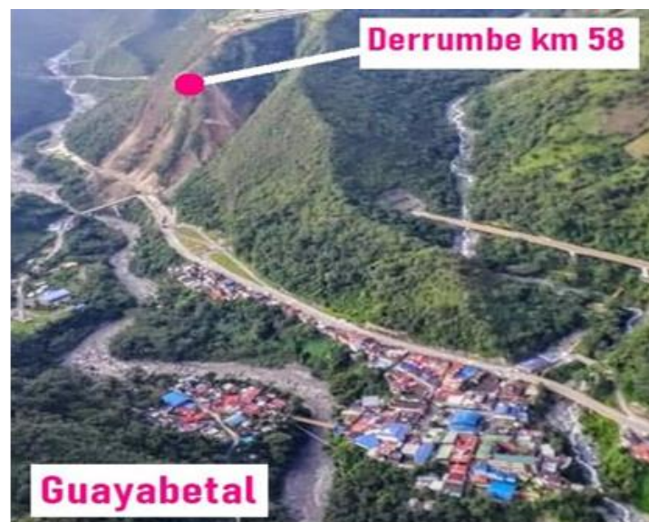
Figura 3. Foto Aérea derrumbe Kilómetro 58, Municipio de Guayabetal
