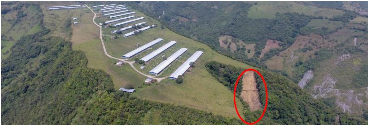
Figura 32. Erosión y deslizamiento en los taludes de Quebrada Seca
