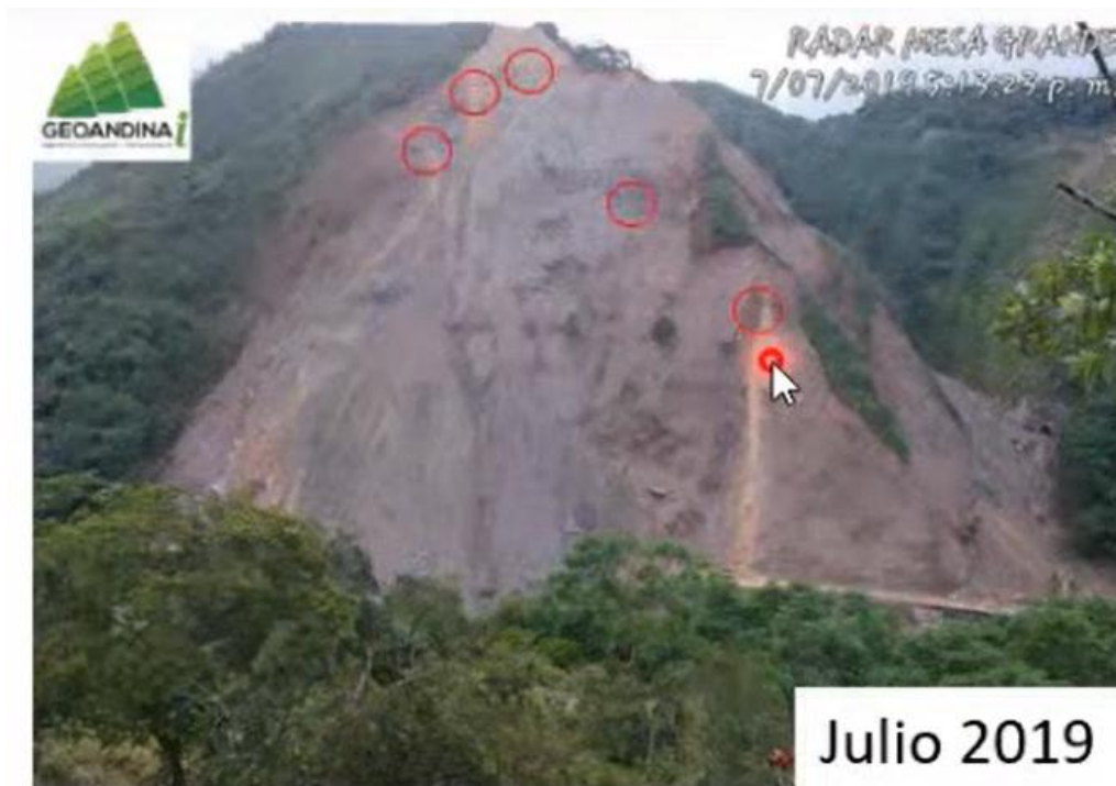
Figura 51. Afloramientos de agua en la ladera
