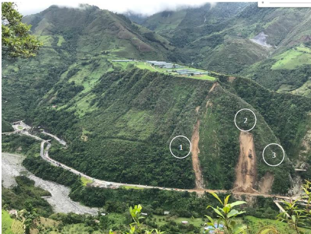
Figura 20. Vista general de los procesos de remoción en masa en la ladera suroccidental de Mesa Grande K58
