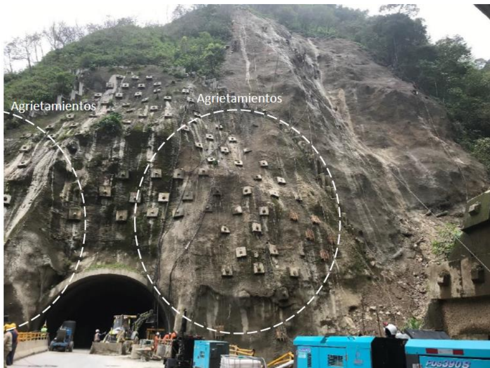
Figura 41. Agrietamiento portal 26
