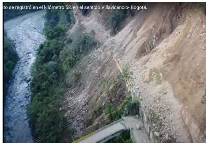
Figura 46. Nuevo deslizamiento K58, 13 de junio
