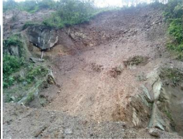
Figura 18. Procesos de remoción en masa y caída de detritos a la vía existente desde la ladera suroccidental de Mesa Grande. Izquierda
