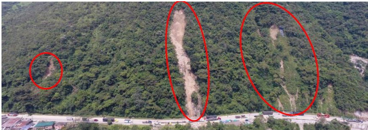
Figura 33. los procesos erosivos iniciados en periodos previos se intensificaron, provocando deslizamientos en la vía y derivando en eventos de remoción en masa
