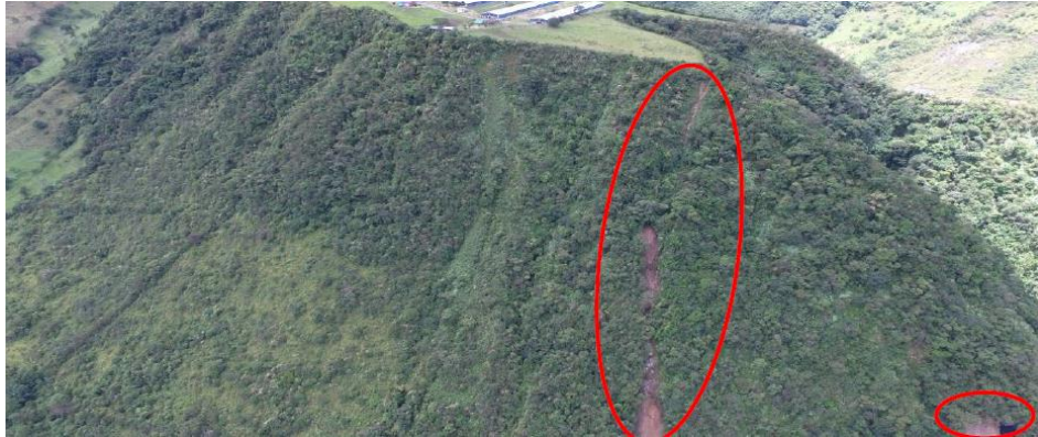
Figura 27. Proceso erosivo superficie de la parte alta del talud por agua de escorrentía y a media ladera por afloramiento de agua de infiltración
