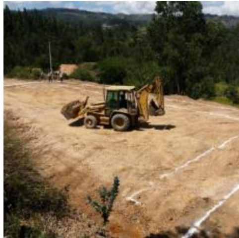
Ilustración 17. Descapote del Terreno.
