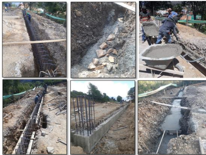
Ilustración 9. Construcción de muro pantalla.
