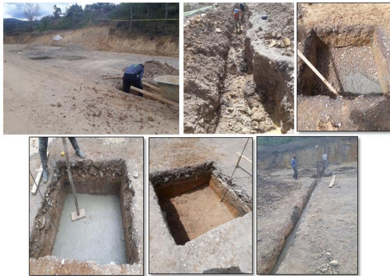
Ilustración 6. Construcción cimentaciones y desagües.
