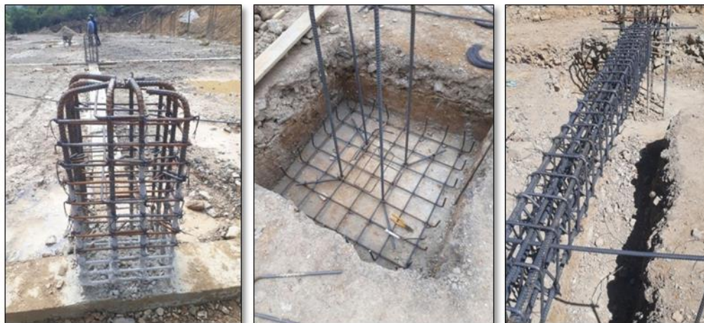
Ilustración 8. Construcción de zapatas y vigas.
