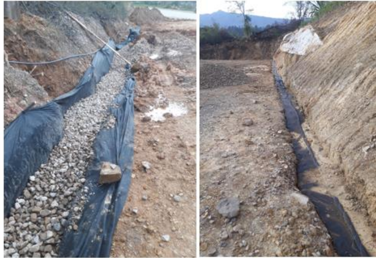
Ilustración 4. Construcción filtro perimetral.
