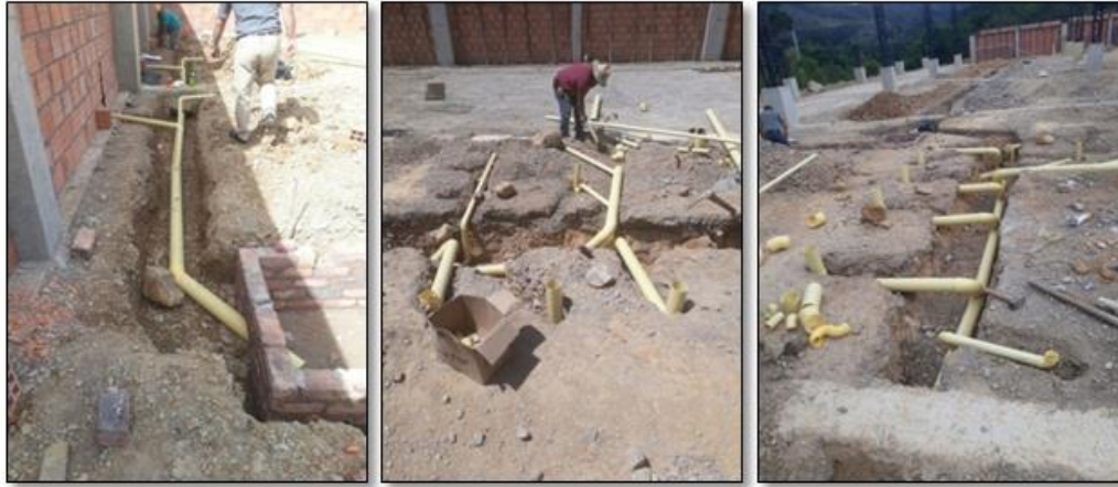
Ilustración 10. Ejecución de instalaciones sanitarias.
