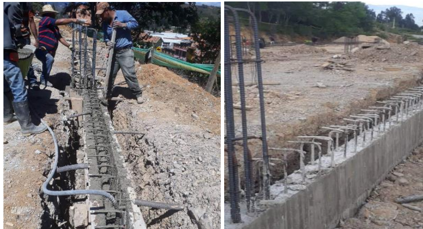
Ilustración 30. Ejecución de muro pantalla.
