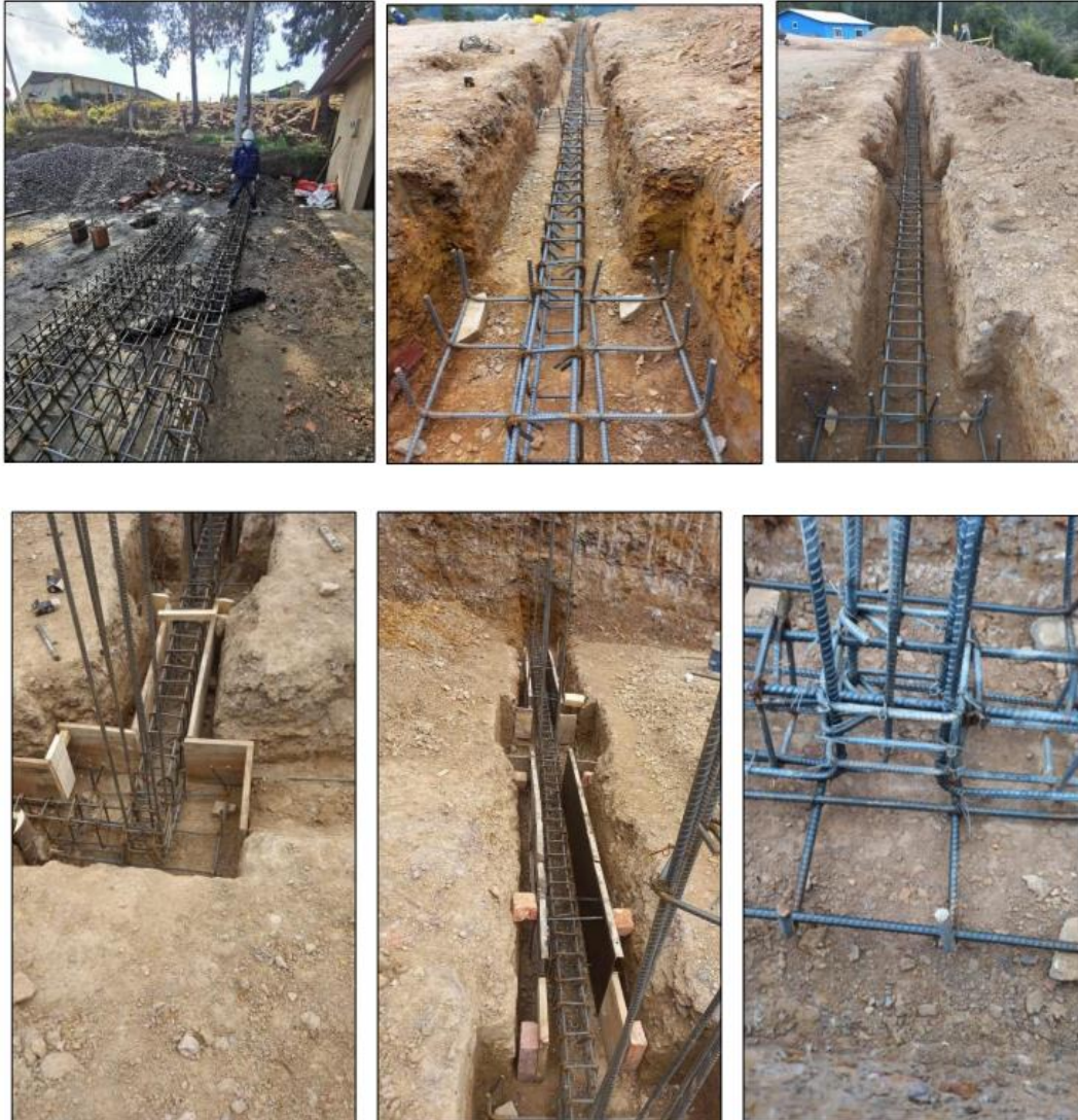
Ilustración 21. Figurado y armado de acero.
