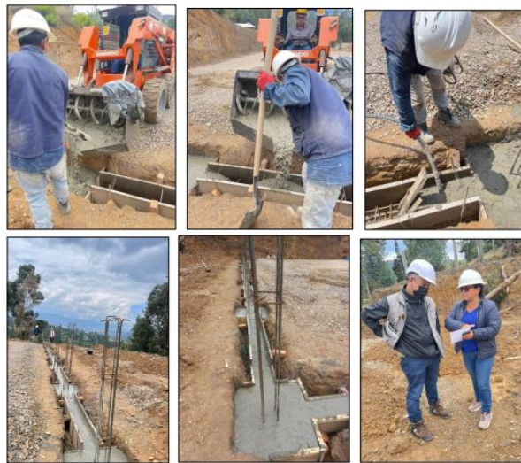
Ilustración 24. Fundida de cimentaciones.
