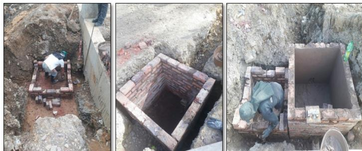
Ilustración 11. Diseño de cajas de Inspección.
