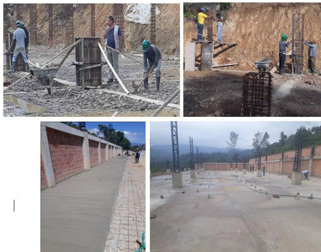
Ilustración 13. Ejecución de placa de piso.
