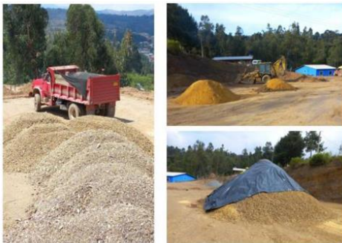
Ilustración 19. Material para Relleno.
