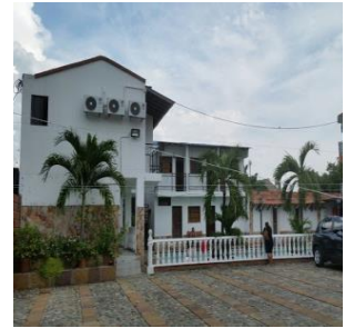
Vista desde el parqueadero
