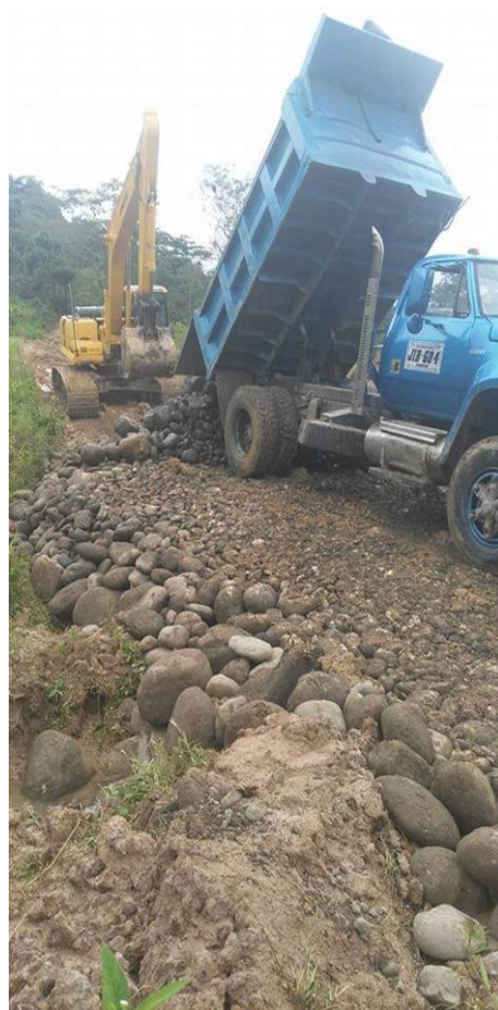
Ilustración 44: Ejecución del Desvío Vial en La Zona de pérdida de La Banca de La Vía San Luis Santa Teresa 2
