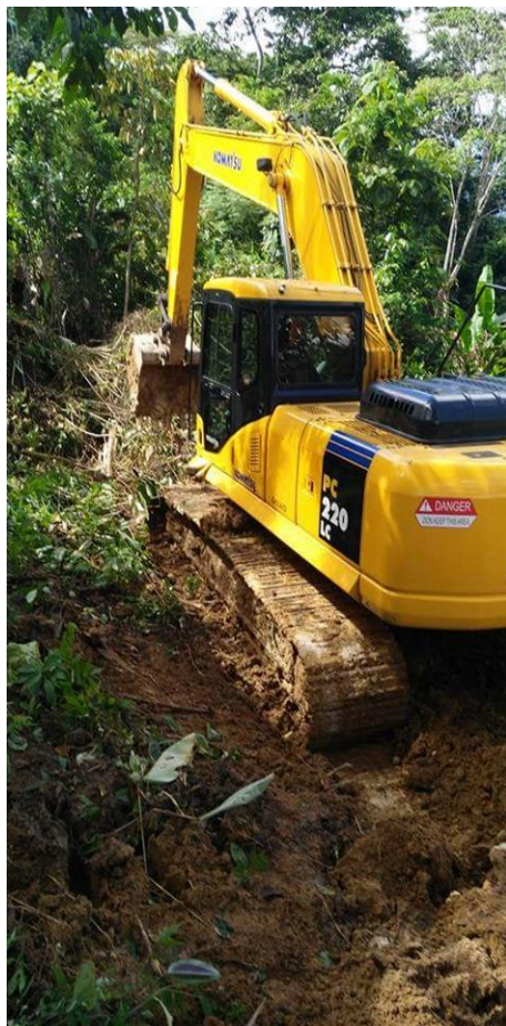
Ilustración 43: Ejecución del Desvío Vial en La Zona de pérdida de La Banca de La Vía San Luis Santa Teresa 1
