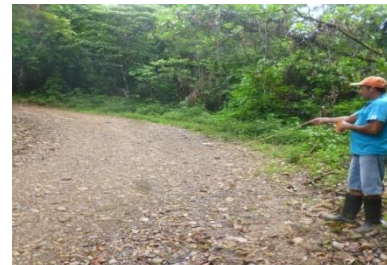
Ilustración 21: Mejoramiento de Vías San Carlos 2
