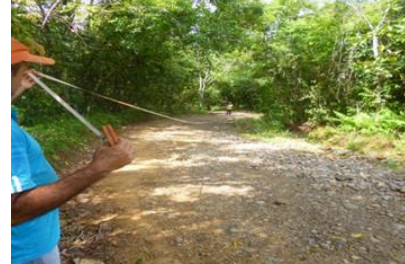
Ilustración 19: Mejoramiento de Vías La Y 2
