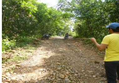
Ilustración 18: Mejoramiento de Vías La Y 1
