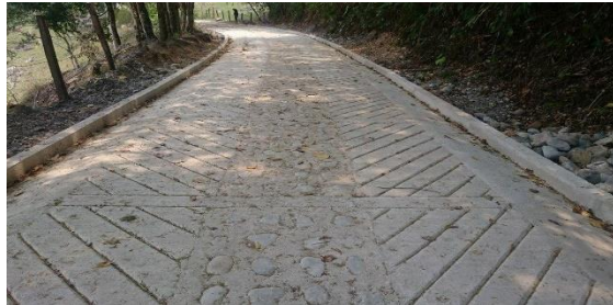
Ilustración 13: Seguimiento Primer Tramo Placa Huella Vereda el Cairo
