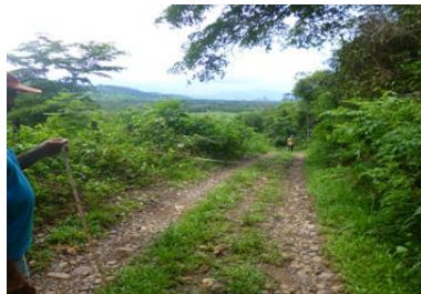
Ilustración 20: Mejoramiento de Vías San Carlos 1
