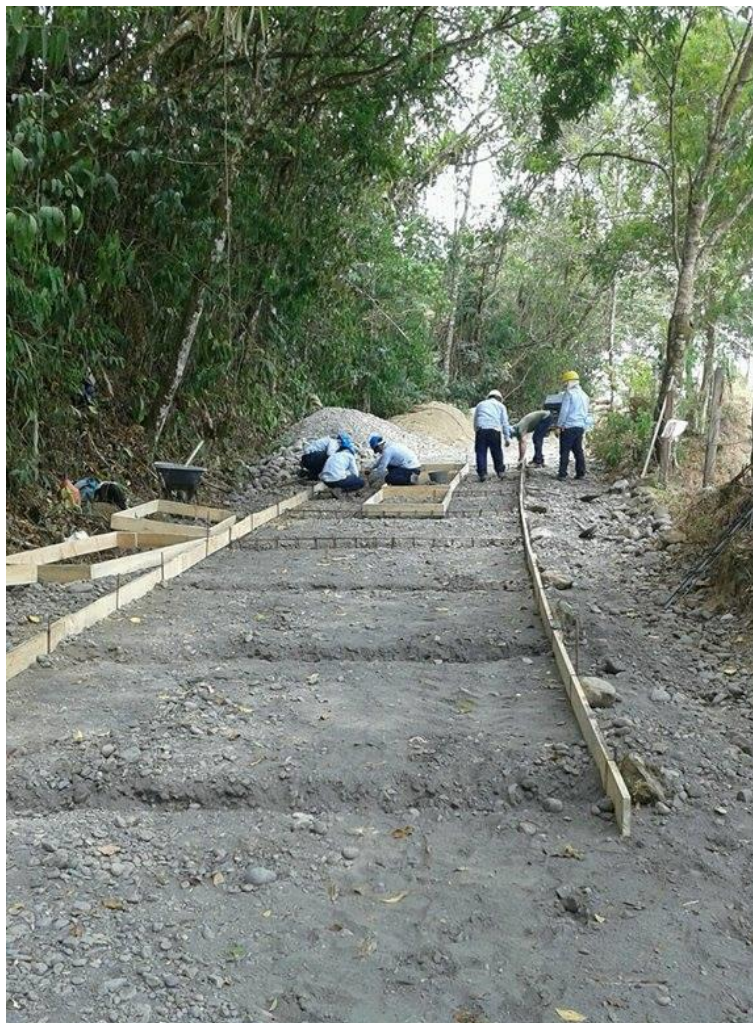
Ilustración 15: Seguimiento Ejecución Obra San Luis El Cairo 3
