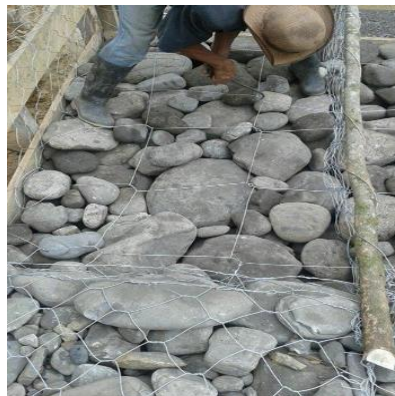
Ilustración 14: Seguimiento Ejecución Obra San Luis El Cairo 2
