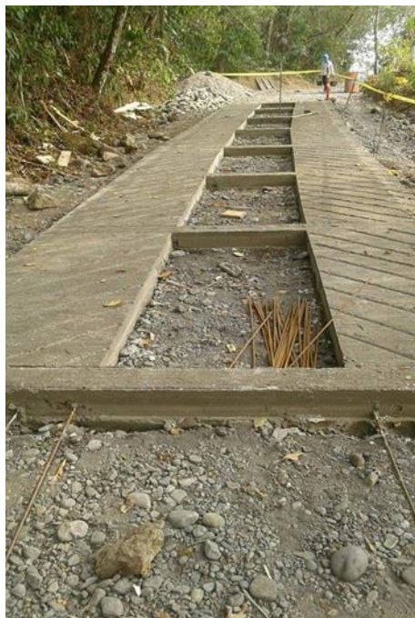
Ilustración 3: Primer Tramo Placa Huella
