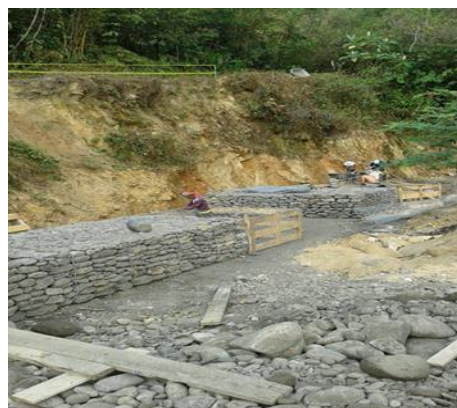
Ilustración 2: Construcción de Gaviones
