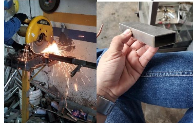
Figura 4. Corte de la tubería
