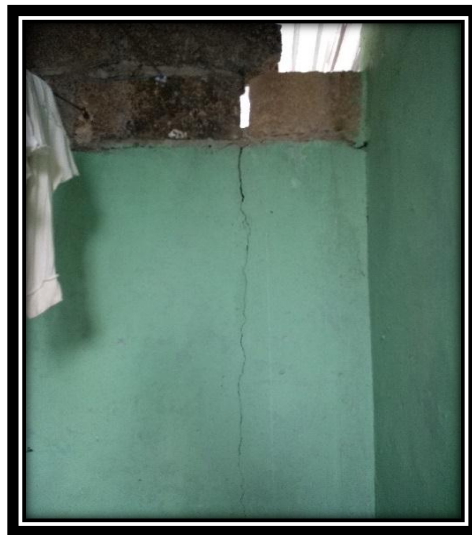
Imagen 81. Estado de conservación
