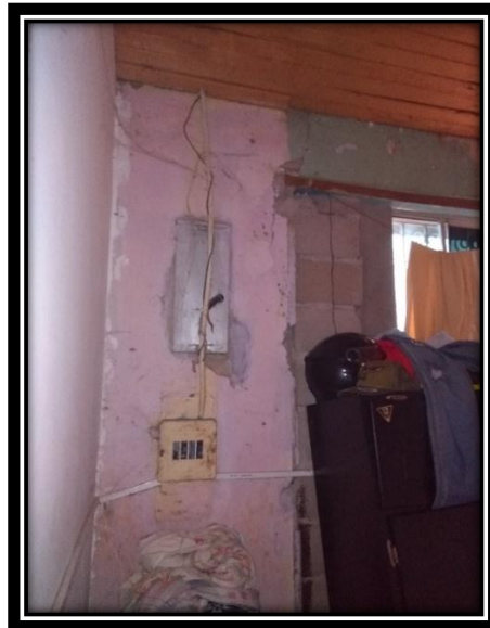
Imagen 75. Estado de cubierta
