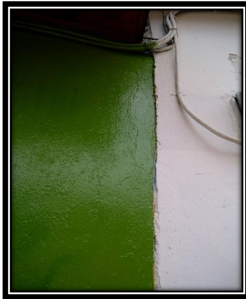
Imagen 71. Estado de conservación
