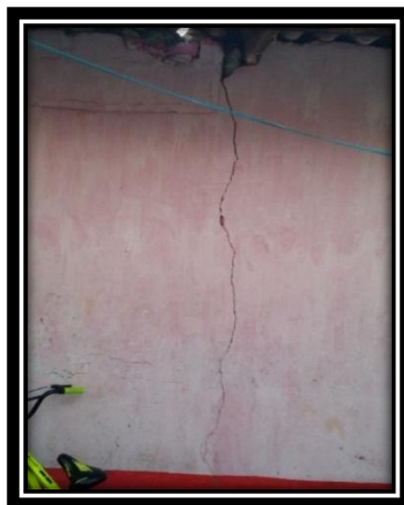
Imagen 61. Estado de conservación
