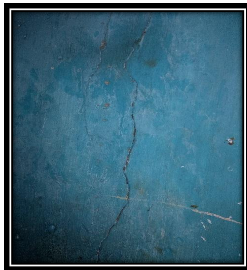
Imagen 76. Estado de conservación
