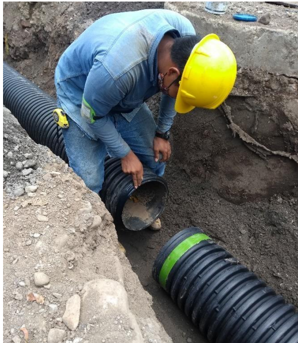
Fotografía 2. Conexión espiga campana.
