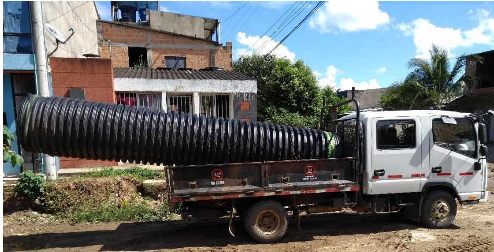
Fotografía 1. Transporte tubería PEAD 28”.
