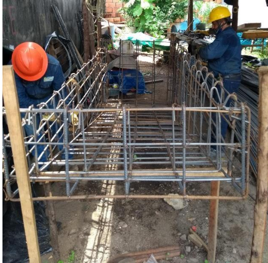
Figura 5. Fotografía de la figuración de hierro, armazón.
