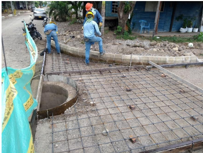
Figura 16. Fotografía de adecuación formaleta y elementos para fundición de placa en concreto rígido.
