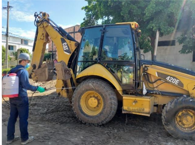
Figura 20. Fotografía de desinfección Retroexcavadora.
