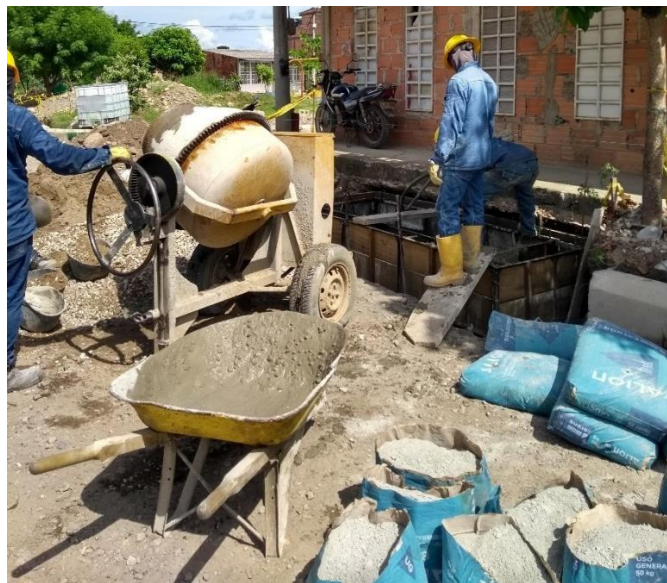
Figura 7. Fotografía de Mezcla de concreto en mezcladora con tambor.
