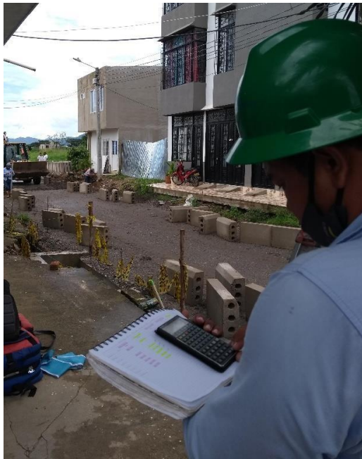
Figura 11. Fotografía de Nivelación sardinel.
