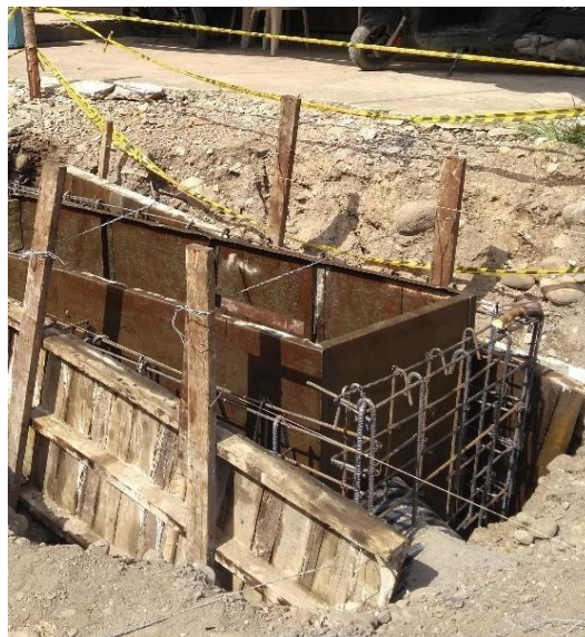
Figura 6. Fotografía de ensamblaje de formaleta.
