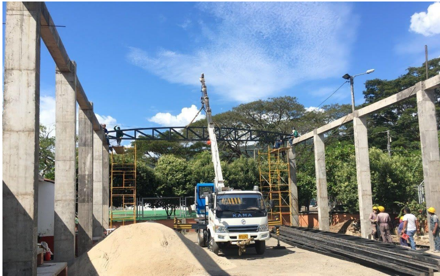
Figura 23. Fotografía de Izaje de cerchas.
