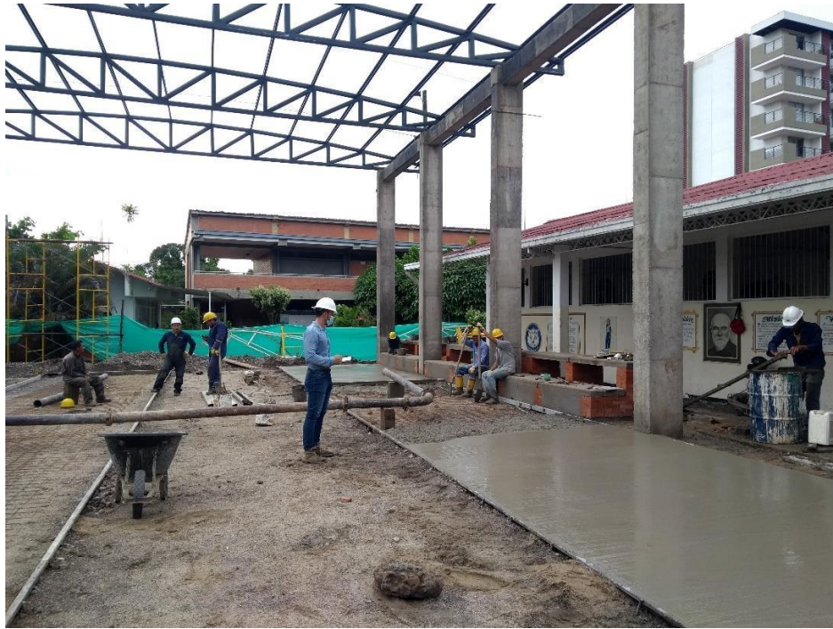
Figura 24. Fotografía de Fundición placa en concreto.
