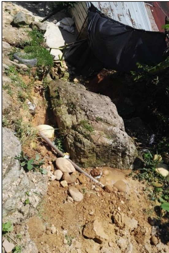
Figura 4-4 Sendero peatonal. Fuente: Propia
