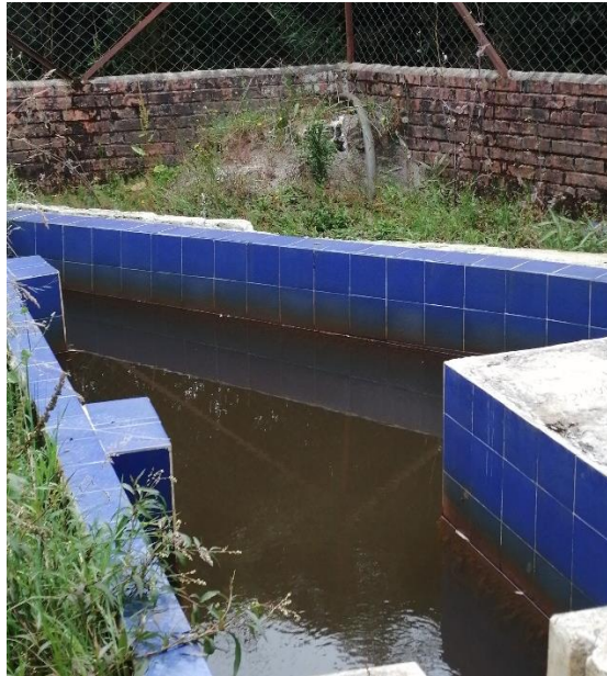
Fotografía 2. Obra de captación Chirquin.
