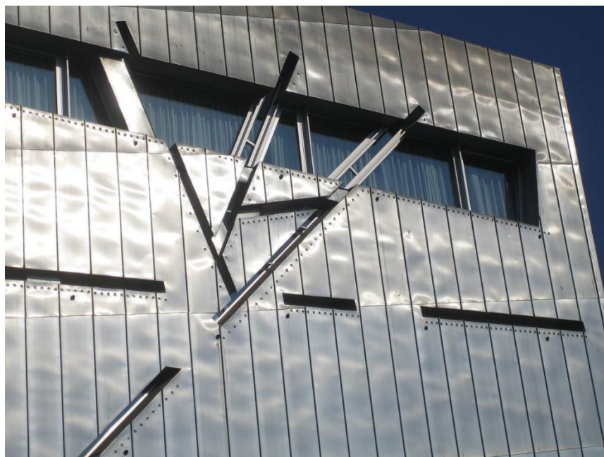
Imagen 2. Vista exterior de las ventanas de las fachadas del museo. Fuente: Google imágenes
