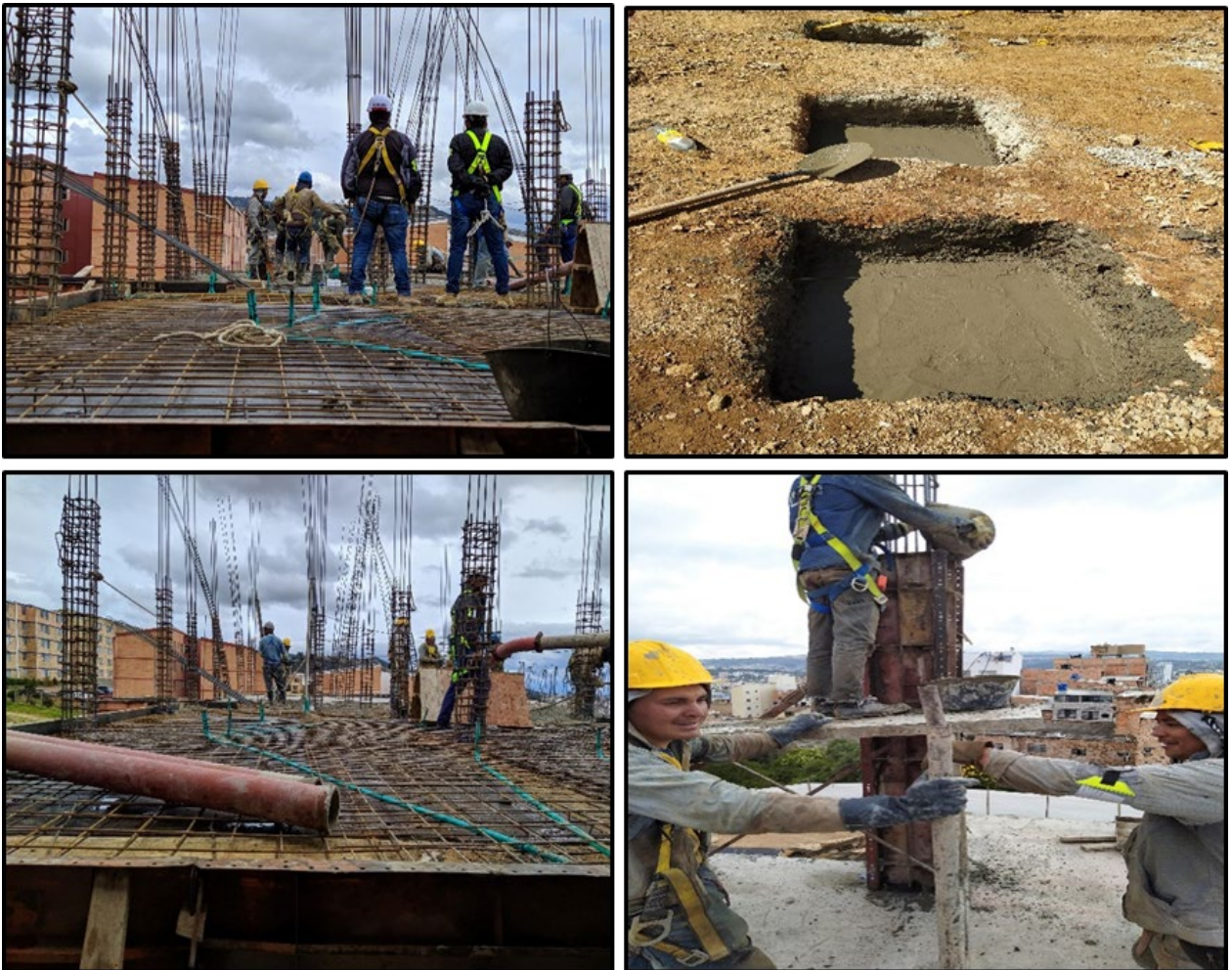
Figura 25. Acompañamiento en fundida de elementos estructurales [FOTO]. Fuente: Elaboración propia, 2019.
