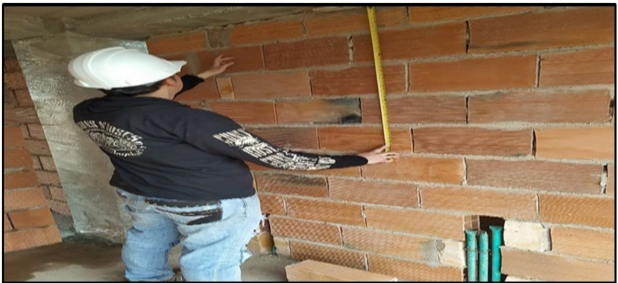
Figura 8. Seguimiento a muros en bloque estándar #4 [FOTO]. Fuente: Elaboración propia, 2019.
