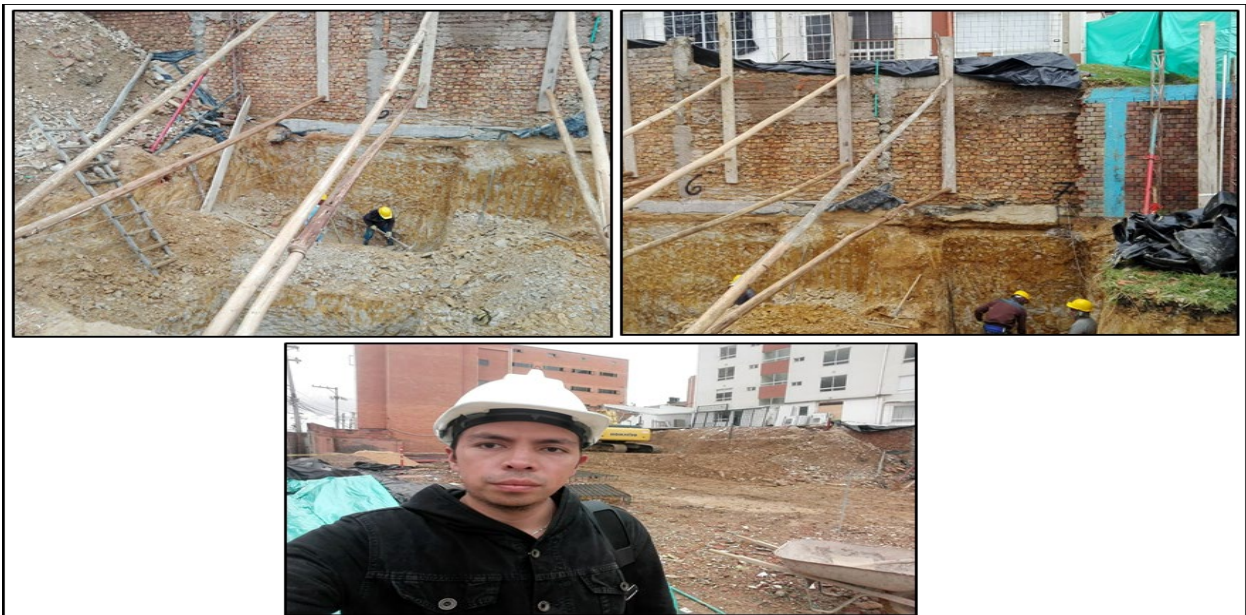
Figura 4. Instalación de apoyos para muro, y excavación para zapatas de la estructura [FOTO]. Fuente: Elaboración propia, 2019.
