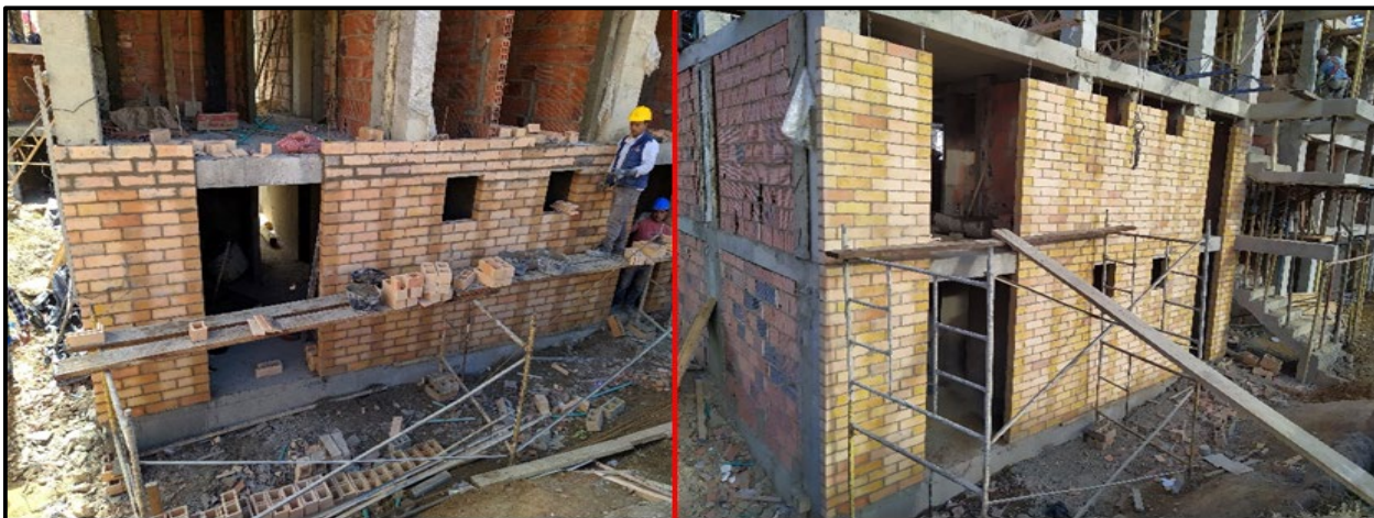
Figura 9. Instalación de ladrillo para fachada [FOTO IZQUIERDA] – Días después de la instalación [FOTO DERECHA]. Fuente: Elaboración propia, 2019.
