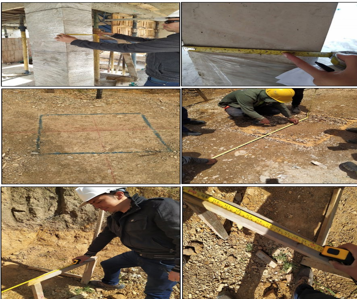
Figura 26. Verificación de medidas en elementos estructurales y ejes [FOTO]. Fuente: Elaboración propia, 2019.
