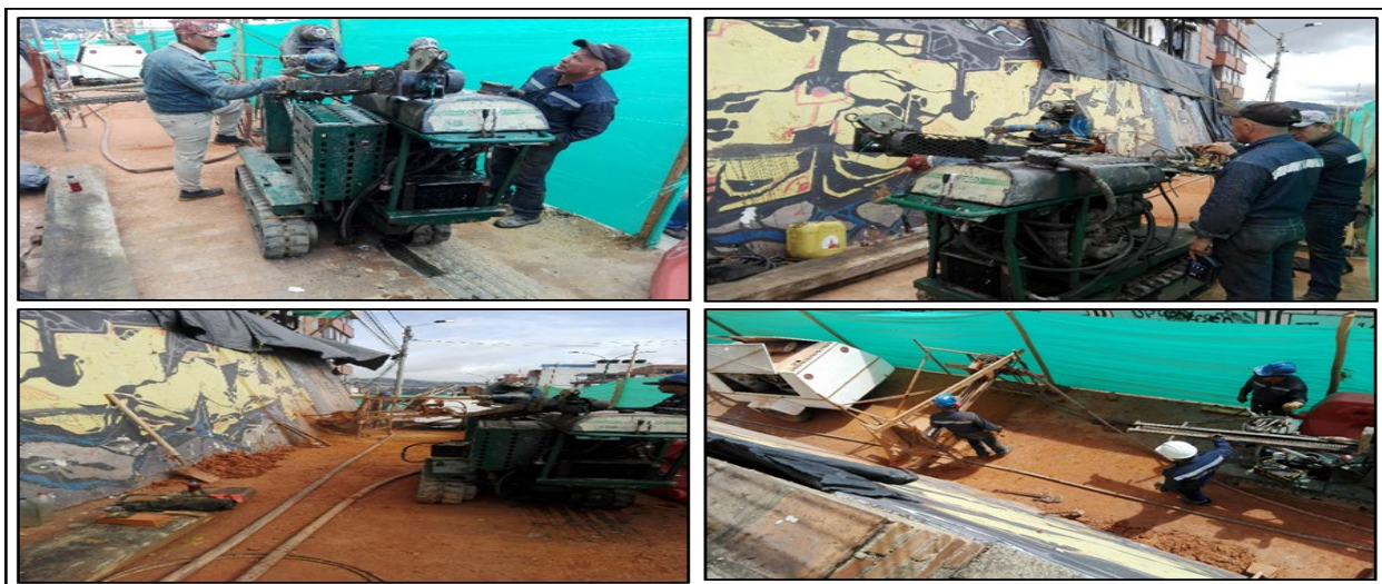
Figura 2. Instalación de maquinaria para perforación y posterior anclaje de la estructura [FOTO]. Fuente: Elaboración propia, 2019.
