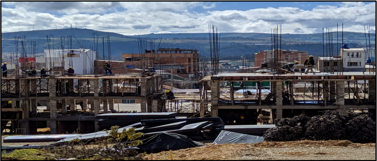
Figura 28. Supervisión a trabajadores realizando trabajo en alturas con su respectivo arnés, punto de anclaje y enganchados a una línea de vida horizontal [FOTO]. Fuente: Elaboración propia, 2019.
