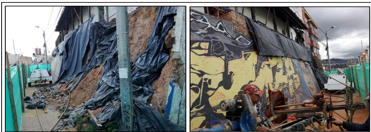
Figura 1. Condiciones iniciales al momento de realizar la primera visita de obra [FOTO]. Fuente: Elaboración propia, 2019.
