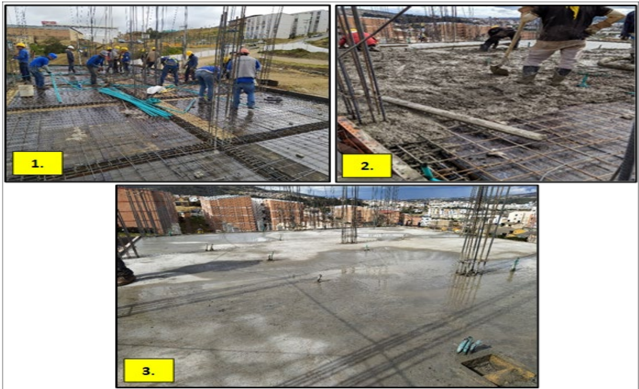
Figura 18. Acompañamiento en fundida de placa de entrepiso [FOTO]. Fuente: Elaboración propia, 2019.
