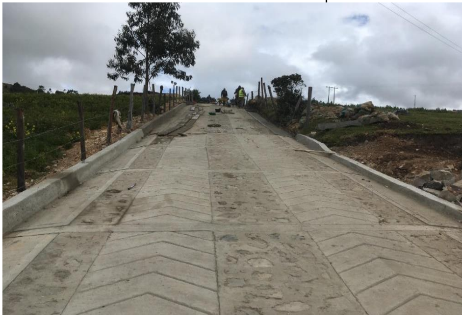
Ilustración 14: Finalización de los últimos módulos del primer tramo
