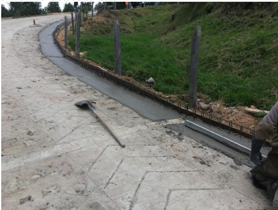
Ilustración 167: Fundida de cunetas
