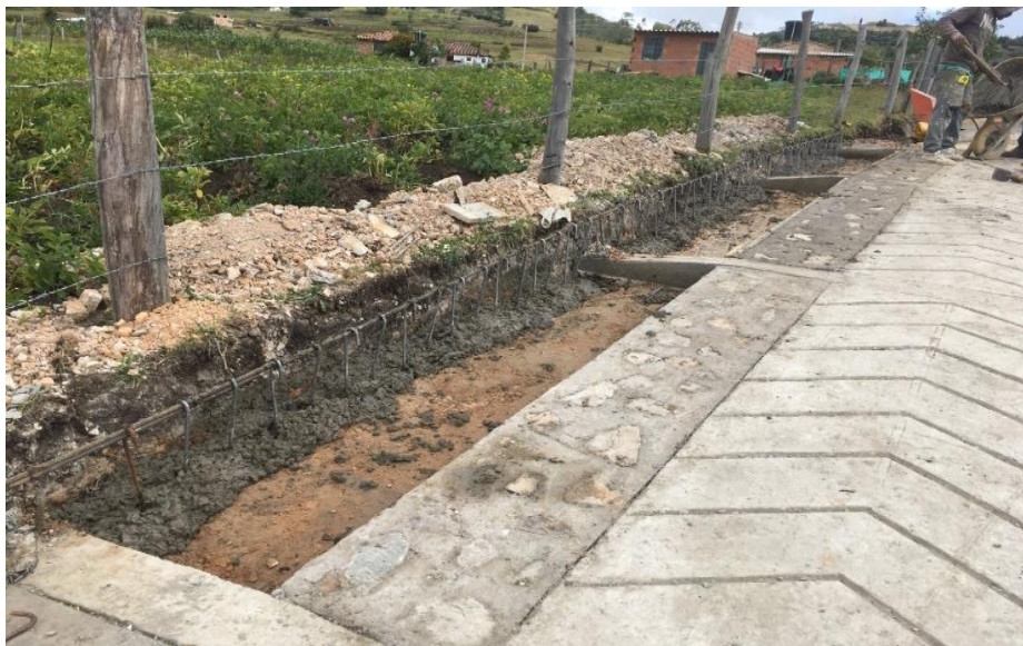
Ilustración 13 Instalación de acero de refuerzo para la construcción del bordillo
