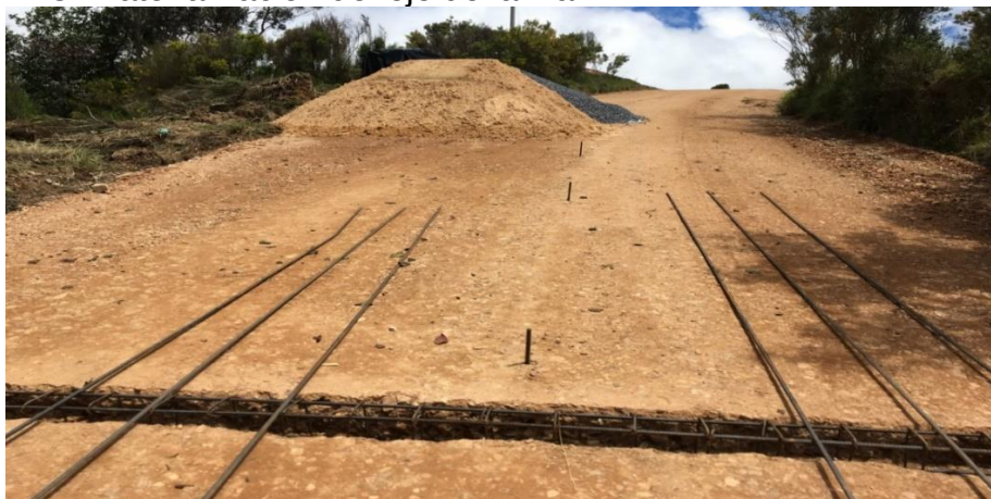
Ilustración 18: Materialización del eje de la vía
