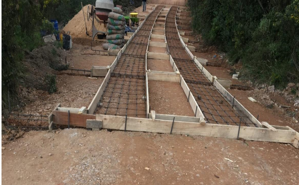
Ilustración 178: Instalación de formaleta tramo 3
