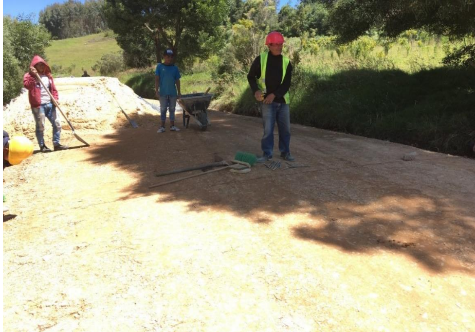
Ilustración 14: Terreno compactado con material afirmado
