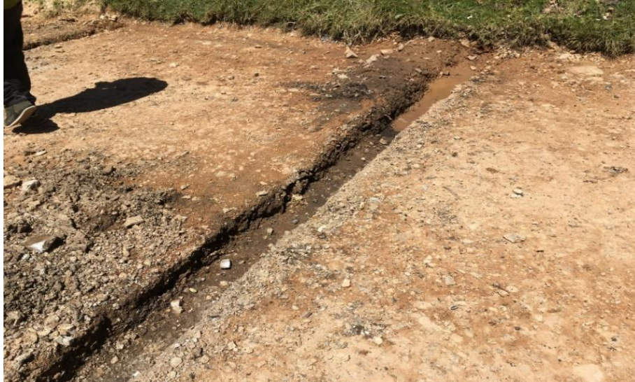
Ilustración 12: Excavación para vigas Riostras
