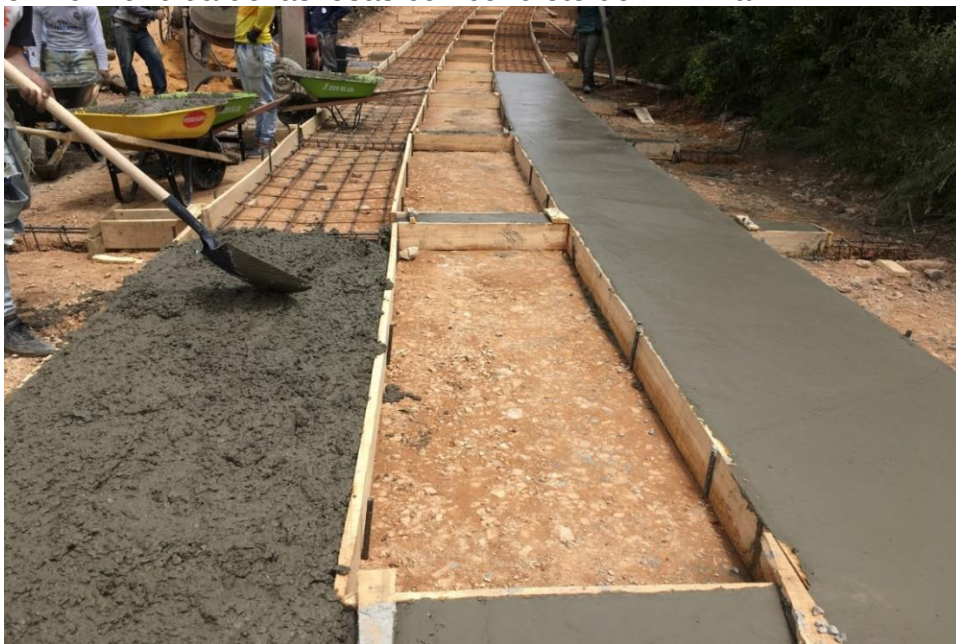
Ilustración 19: Fundida de las losas con concreto de 21 MPa
