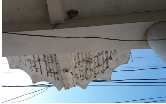
Fotografías 13 y 14. Desprendimiento del concreto en vigas y losa.
