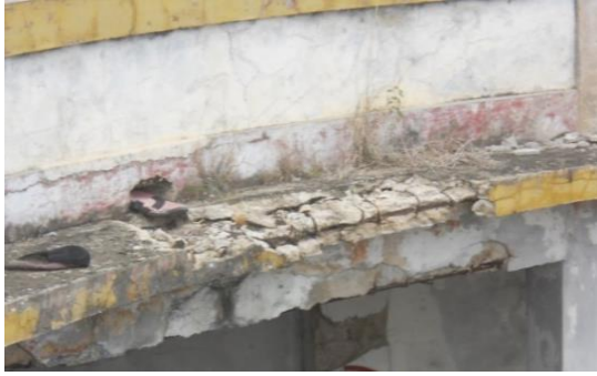
Fotografías 13 y 14. Desprendimiento del concreto en vigas y losa.
