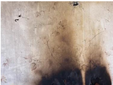
Fotografía 15 y 16. Manchas de humo y quemaduras en muros y columnas.
