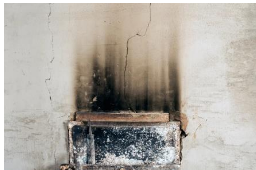
Fotografía 15 y 16. Manchas de humo y quemaduras en muros y columnas.
