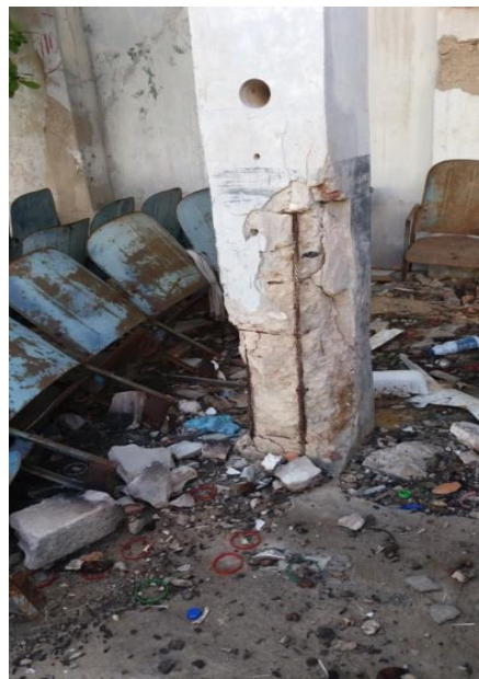
Fotografías 11 y 12. Desprendimiento del concreto en columnas.
