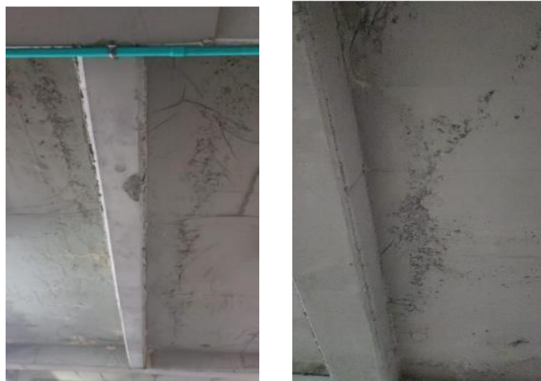
Imagen 7y 8. Segregación en parte inferior los maciza.
