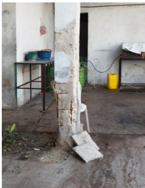
Fotografías 11 y 12. Desprendimiento del concreto en columnas.
