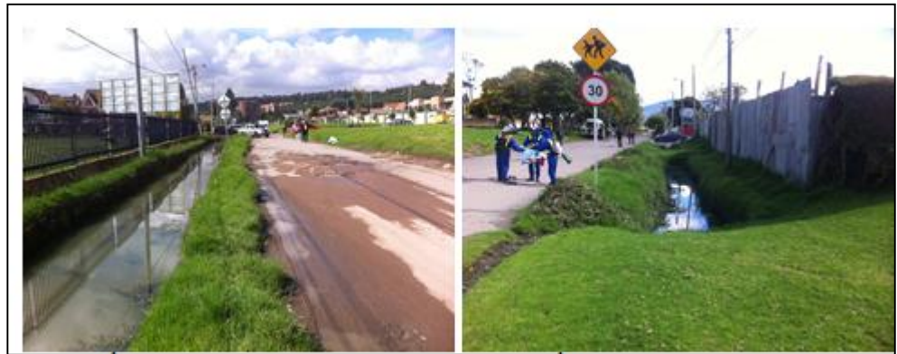
Figura 8.Estado actual drenaje en el área de localización del Proyecto.
