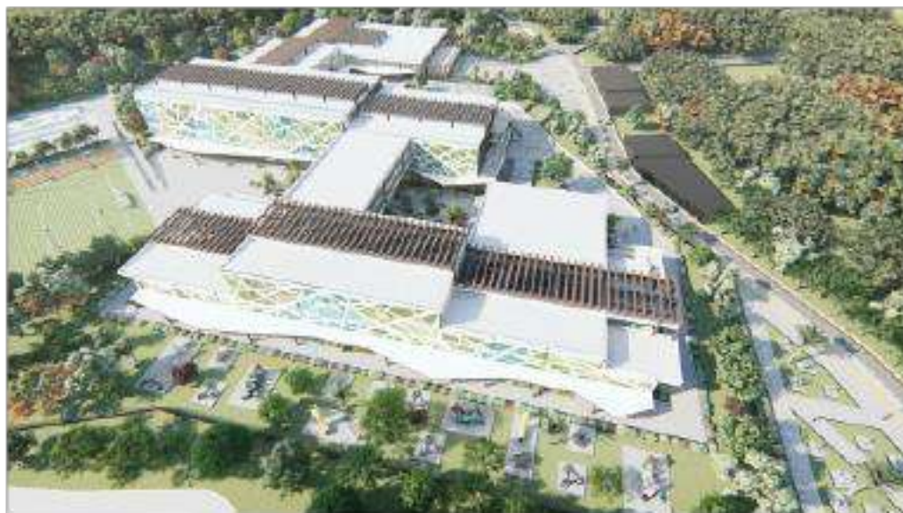
Ft. 43 Fachada lateral izquierda Autores: Diana Carolina Torres y Andrés Velasco
