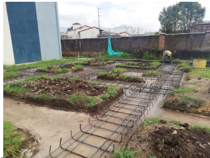
Anexo 18. Avance cimentación torre 3.
