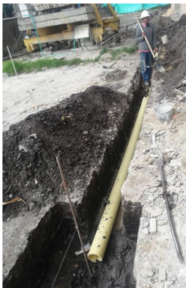
ANEXO 7. Excavación e instalación tubería pluvial T-1.
