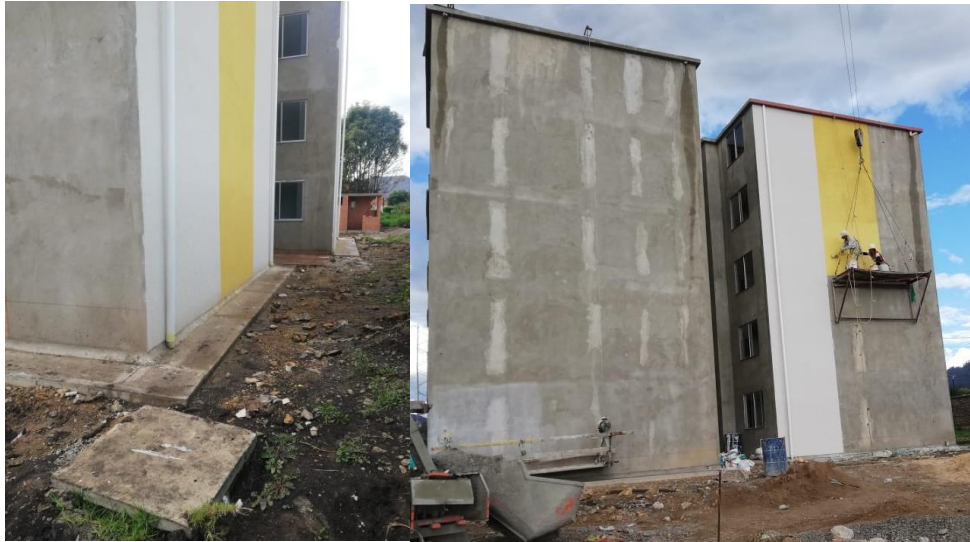
ANEXO 19. Supervisión aplicación de graniplast Torre 1.
