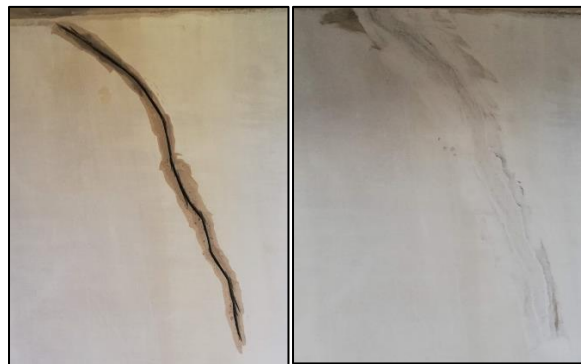
ANEXO 2. Reparación De Microfisuras Torre 1 SIKA 121 De 2 Componentes Apto 504 Y 503 Torre 1.
