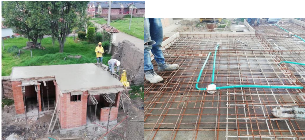
ANEXO 16. Fundida placa de entre piso punto de control.
