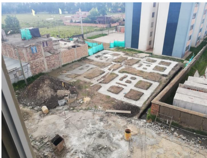
ANEXO 12. Fundida Concreto Ciclópeo Torre 3.
