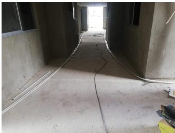
ANEXO 10. Instalación de red de gas 1er piso Torre 1.
