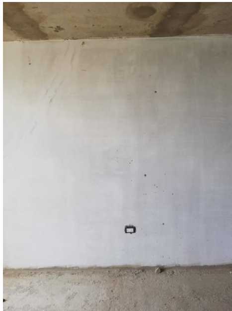
ANEXO 6. Reparación De Microfisuras Torre 1 5To Piso SIKa 121 monocomponente Apto 505 y 506 Torre 1.
