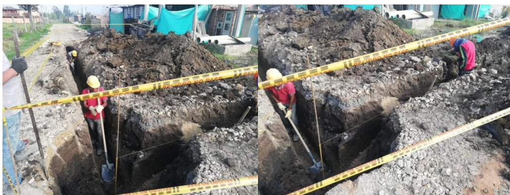
ANEXO 14. Supervisión A Instalación De Tubería Pluvial.
