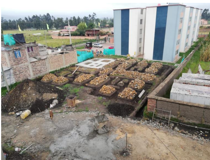
ANEXO 11. Fundida Concreto Ciclópeo Torre 3.
