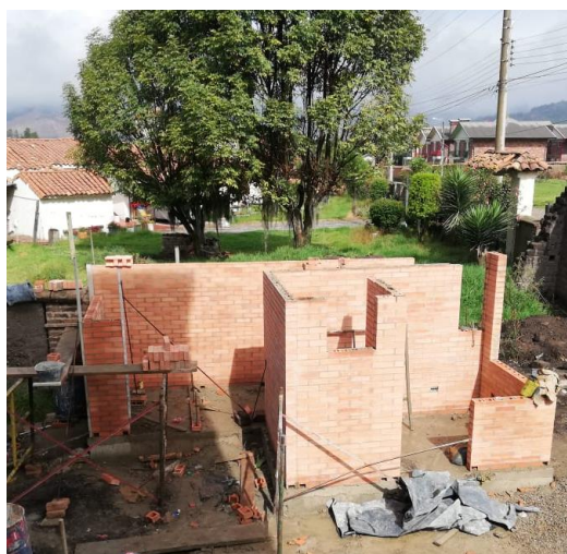
ANEXO 15. Avance punto de control.
