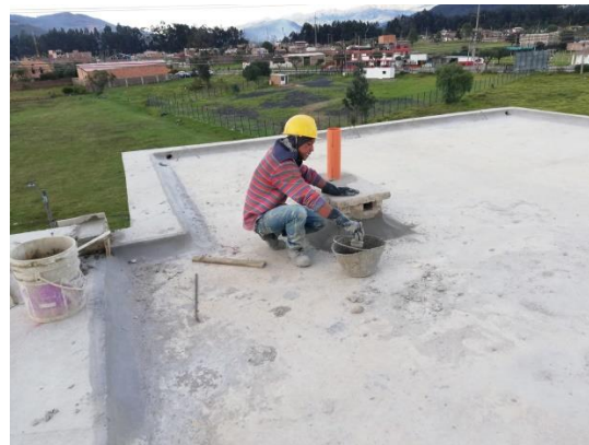
ANEXO 3. Construcción De Medias Cañas Torre 1 Placa 5to Piso.
