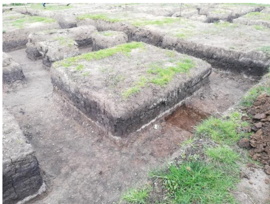
ANEXO 8. Excavación de dados en la cimentación T-3.
