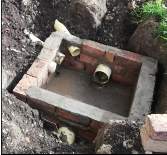
ANEXO 5. Construcción de cajas de inspección pluvial.
