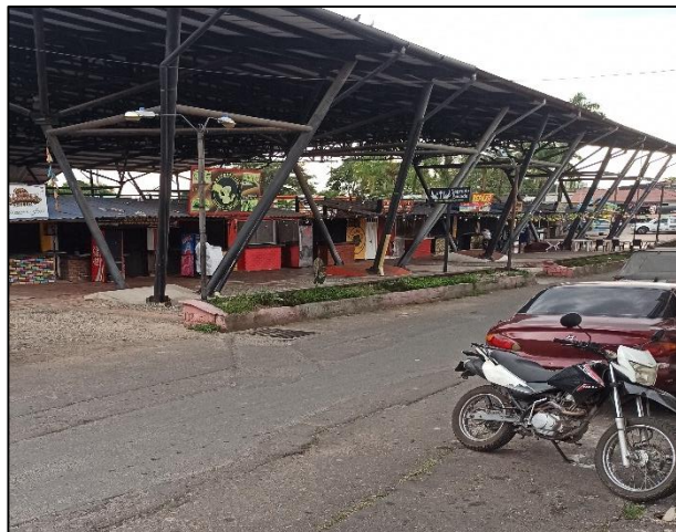
Fotografía 1 (Ubicación de la vía para mejorar - vista real, Fuente: Autor).
