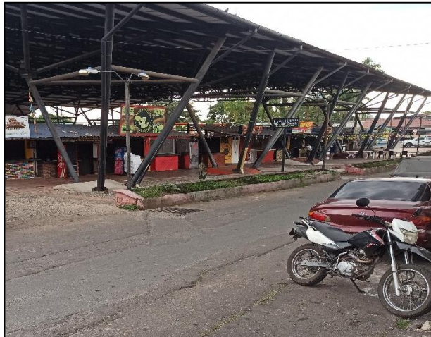
Fotografía 3 (Estado de la vía - Calle 10, Fuente: Autor).
