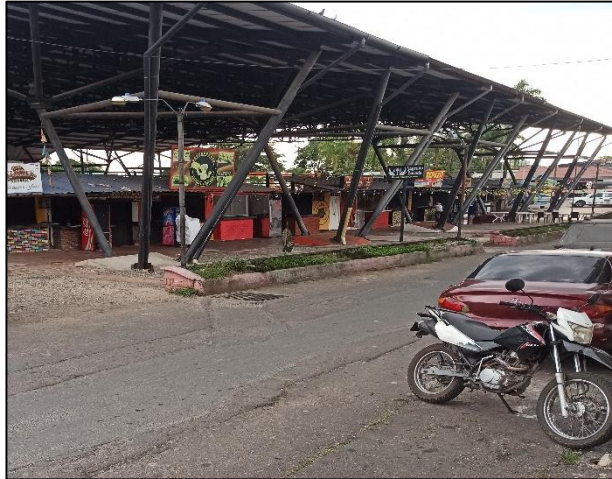
Fotografía 2 (Estado de la vía - Calle 10, Fuente: Autor).
