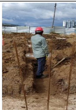
#84 Excavación cimentación plazoleta 3
