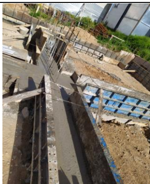
#35 Fundida de elementos de cimentación
