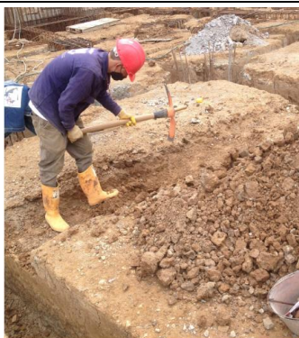
#3 Excavación manual de dados y vigas de cimentación
