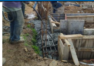
#118 Fundida de elementos de cimentación plazaola 3
