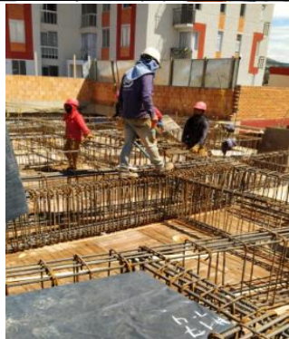
#124 Amarre de refuerzo para elementos de entrepiso
