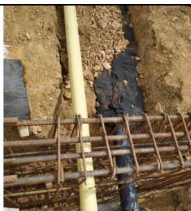
#64 Instalación del sistema de drenaje
