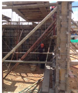
#82 Encofrado de secciones
