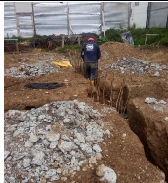
#4 Excavación manual de dados y vigas de cimentación
