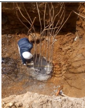
#11 Verificación de localización de los pilotes
