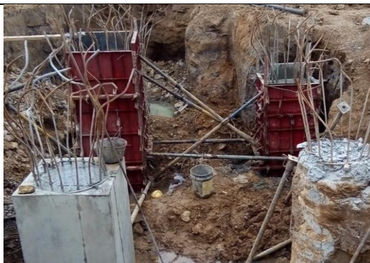
#62 Demolición y reparación de pilotes
