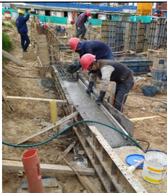
#39 Fundida de elementos de cimentación
