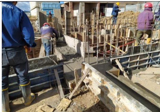
#36 Fundida de elementos de cimentación
