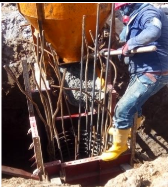
#59 Demolición y reparación de pilotes
