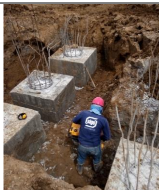
#10 Compactación de relleno de excavaciones y capa de base
