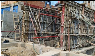
#95 Fundida de muros
