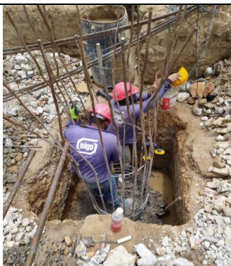
#23 Descabece de pilotes
