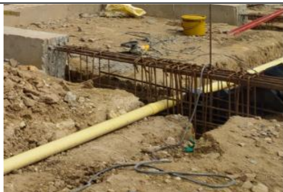
#63 Instalación del sistema de drenaje
