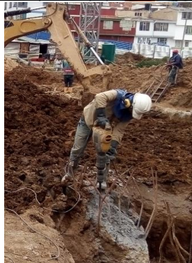
#22 Descabece de pilotes
