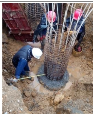
#12 Verificación de localización de los pilotes
