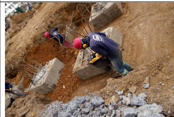
#9 Compactación de relleno de excavaciones y capa de base
