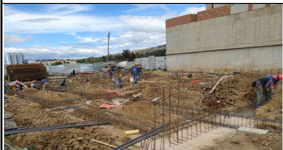
#107 Amarre de refuerzo de zapatas y vigas de cimentación plazoleta 3
