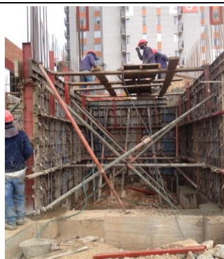
#76 Encofrado de secciones
