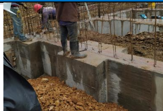
#74 Amarre de refuerzo en muros
