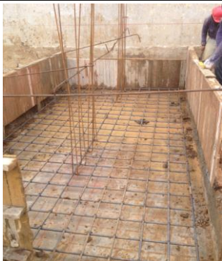
#103 Amarre de refuerzo de zapatas y vigas de cimentación plazoleta 3
