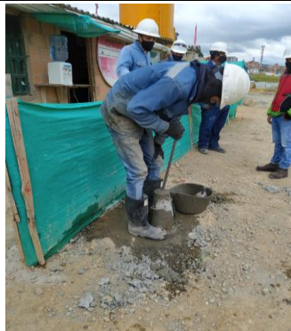
#100 Ensayo de asentamiento - CONO DE ABRAMS
