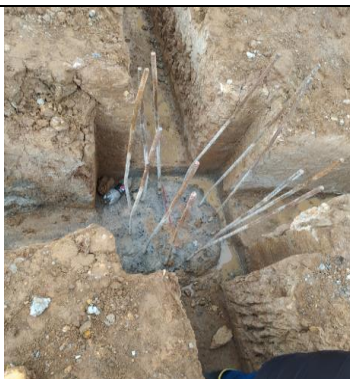
#15 Verificación de localización de los pilotes
