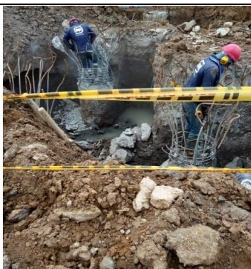
#61 Demolición y reparación de pilotes
