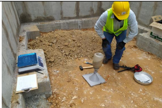
#122 Toma de densidades en relleno y capa de base
