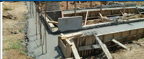
#117 Fundida de elementos de cimentación plazaola 3
