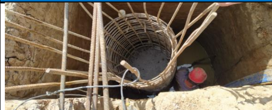
#51 Demolición y reparación de pilotes
