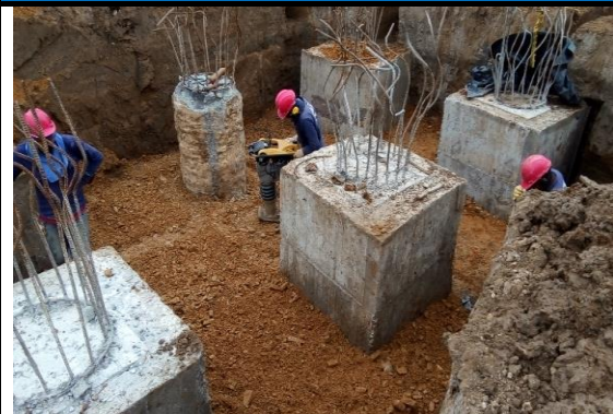
#7 Compactación de relleno de excavaciones y capa de base
