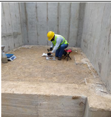
#117 Toma de densidades en relleno y capa de base
