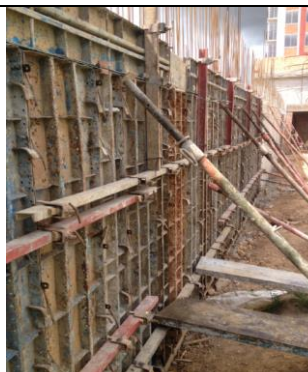
#80 Encofrado de secciones
