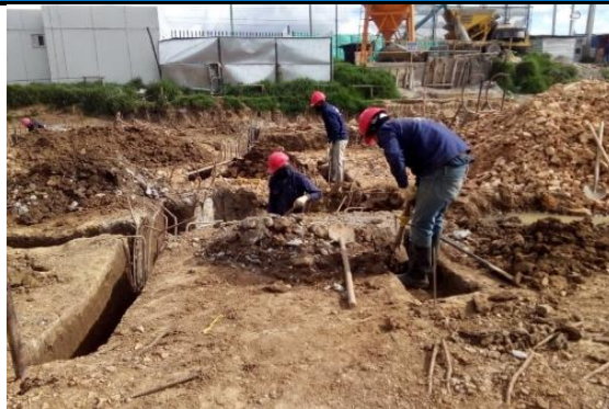
#2 Excavación manual de dados y vigas de cimentación
