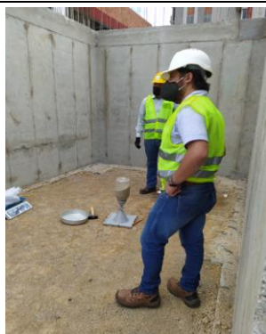
#119 Toma de densidades en relleno y capa de base
