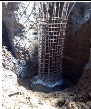
#60 Demolición y reparación de pilotes
