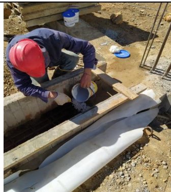
#40 Fundida de elementos de cimentación
