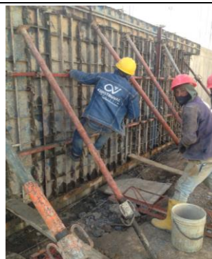
#78 Encofrado de secciones
