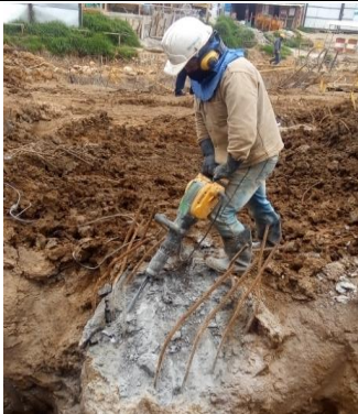
#21 Descabece de pilotes
