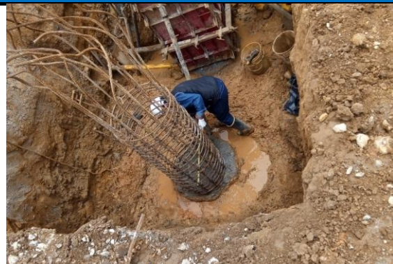
#13 Verificación de localización de los pilotes
