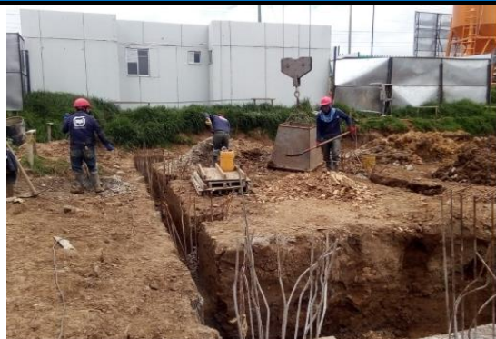
#1 Excavación manual de dados y vigas de cimentación
