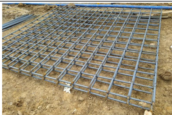
#105 Amarre de refuerzo de zapatas y vigas de cimentación plazoleta 3
