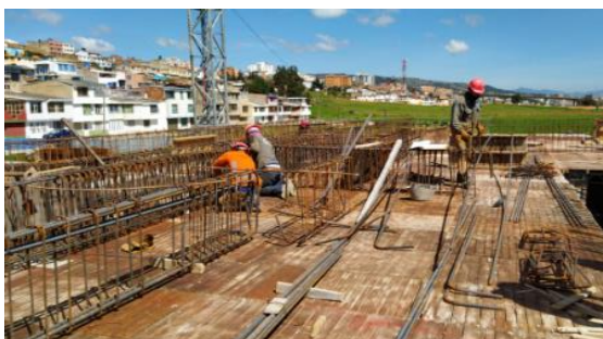
#125 Amarre de refuerzo para elementos de entrepiso
