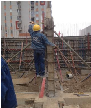
#81 Encofrado de secciones
