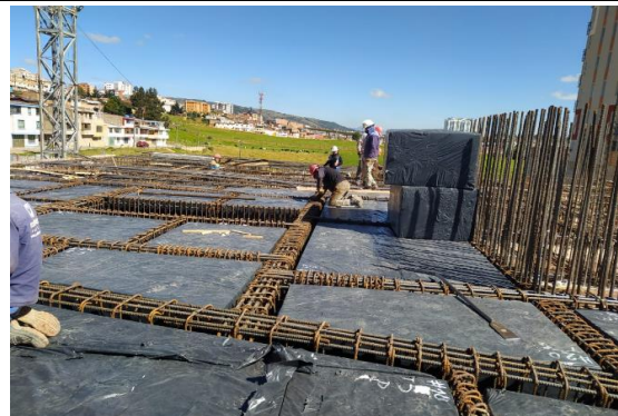
#123 Amarre de refuerzo para elementos de entrepiso
