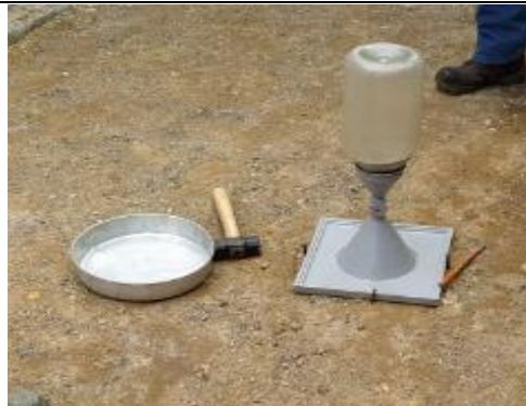
#120 Toma de densidades en relleno y capa de base
