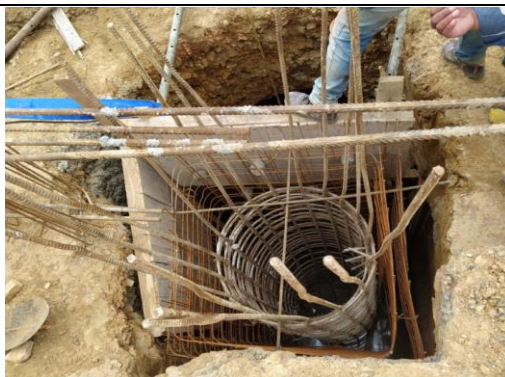
#56 Demolición y reparación de pilotes
