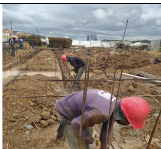
#108 Amarre de refuerzo de zapatas y vigas de cimentación plazoleta 3
