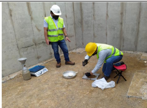
#118 Toma de densidades en relleno y capa de base
