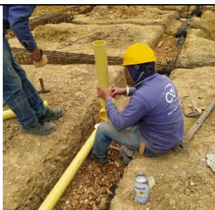
#63 Instalación del sistema de drenaje
