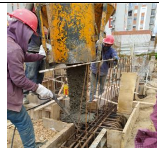
#41 Fundida de elementos de cimentación
