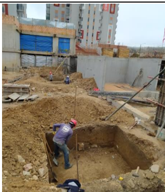
#85 Excavación cimentación plazoleta 3
