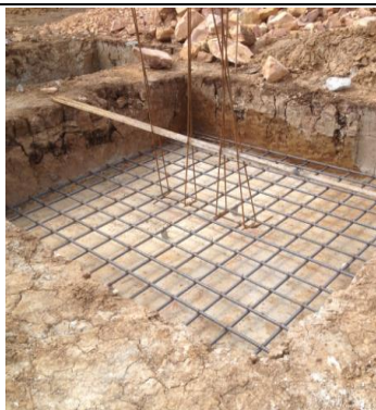
#106 Amarre de refuerzo de zapatas y vigas de cimentación plazoleta 3
