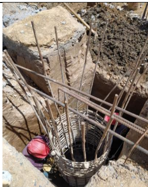
#55 Demolición y reparación de pilotes
