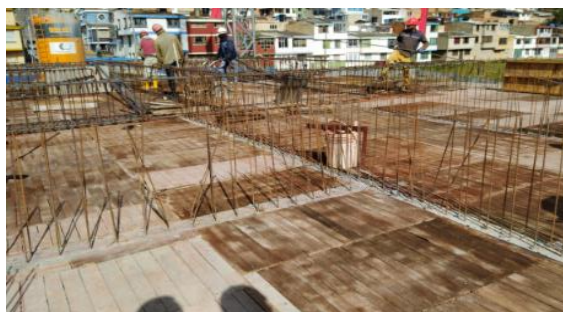
#126 Amarre de refuerzo para elementos de entrepiso
