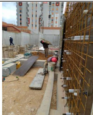
#77 Encofrado de secciones
