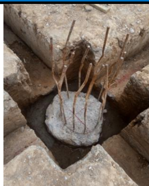
#14 Verificación de localización de los pilotes
