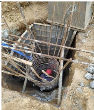
#53 Demolición y reparación de pilotes
