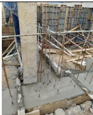
#42 Fundida de elementos de cimentación
