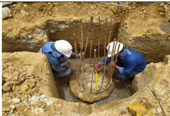
#16 Verificación de localización de los pilotes
