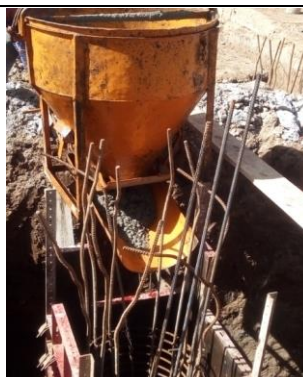
#58 Demolición y reparación de pilotes
