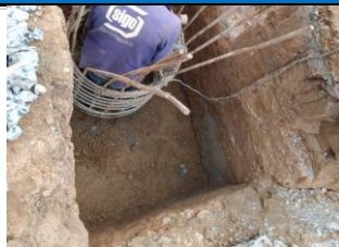
#52 Demolición y reparación de pilotes
