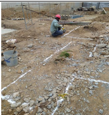
#83 Replanteo de cimentación plazoleta 3
