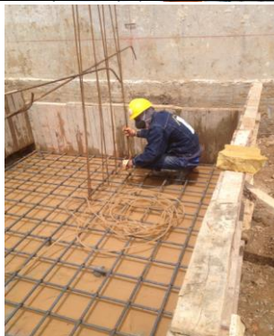
#104 Amarre de refuerzo de zapatas y vigas de cimentación plazoleta 3
