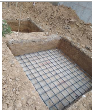
#107 Amarre de refuerzo de zapatas y vigas de cimentación plazoleta 3
