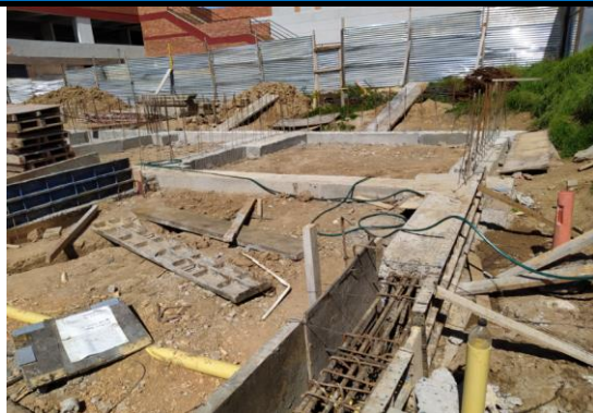
#37 Fundida de elementos de cimentación
