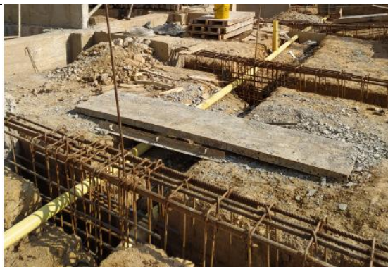
#64 Instalación del sistema de drenaje
