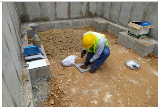
#121 Toma de densidades en relleno y capa de base
