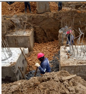
#5 Compactación de relleno de excavaciones y capa de base
