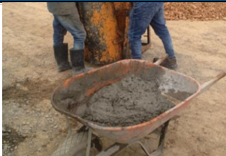
#96 Toma de muestras y ensayo de laboratorio calidad de concreto fundido en obra
