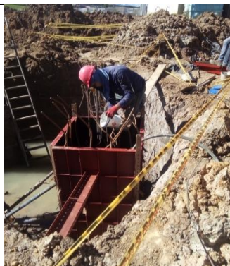
#57 Demolición y reparación de pilotes
