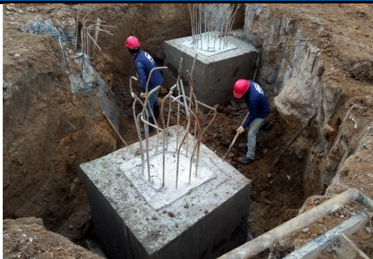
#8 Compactación de relleno de excavaciones y capa de base
