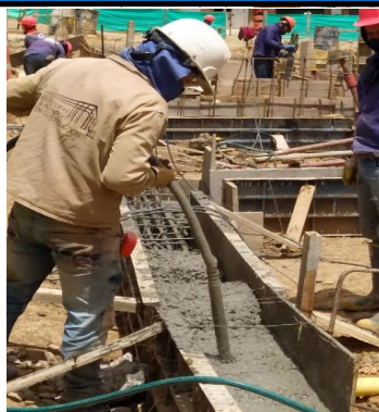
#38 Fundida de elementos de cimentación
