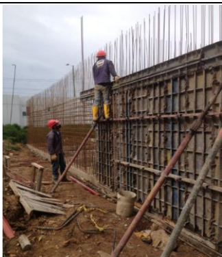
#75 Encofrado de secciones
