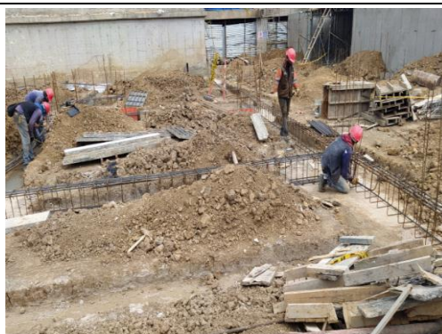
#108 Amarre de refuerzo de zapatas y vigas de cimentación plazoleta 3
