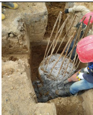
#54 Demolición y reparación de pilotes
