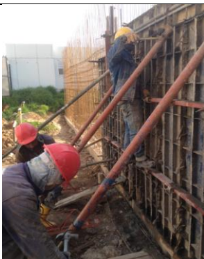
#79 Encofrado de secciones
