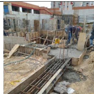
#42 Fundida de elementos de cimentación
