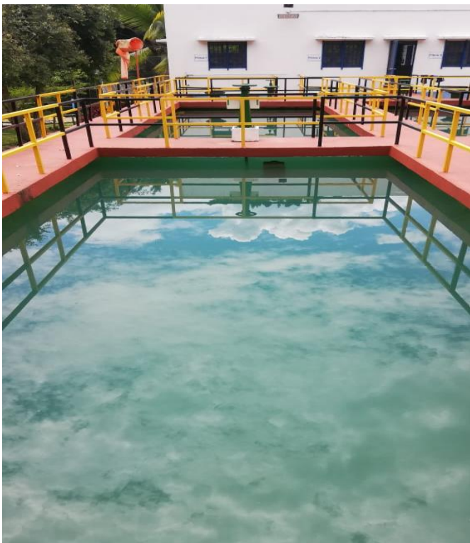
Figura 3 Planta de tratamiento de agua potable-PTAP C.V
