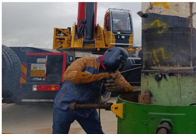
Figura 3. Actividades de soldadura – Hincado de tubo conductor
