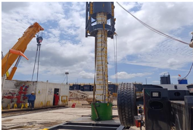
Figura 4. Hincado de tubo conductor 20" OD
