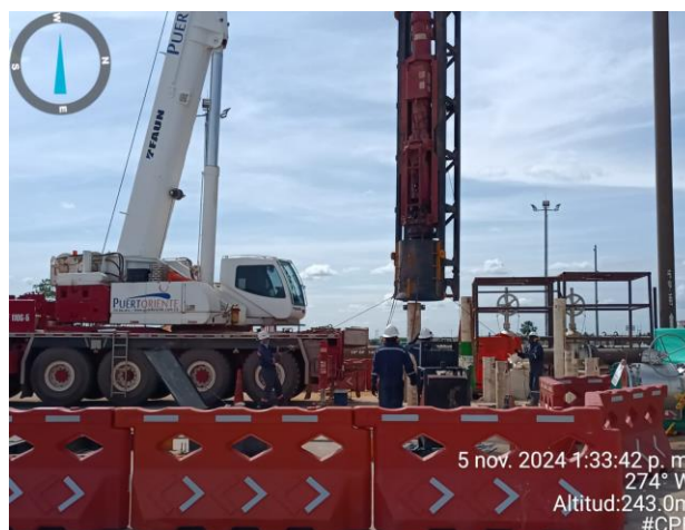
Figura 5. Hincado de pilotes de 12" OD
