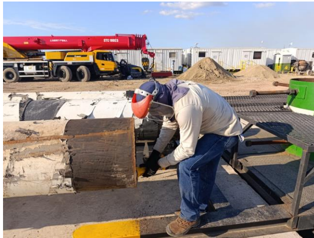
Figura 2. Actividades de pulidora - Hincado de tubo conductor
