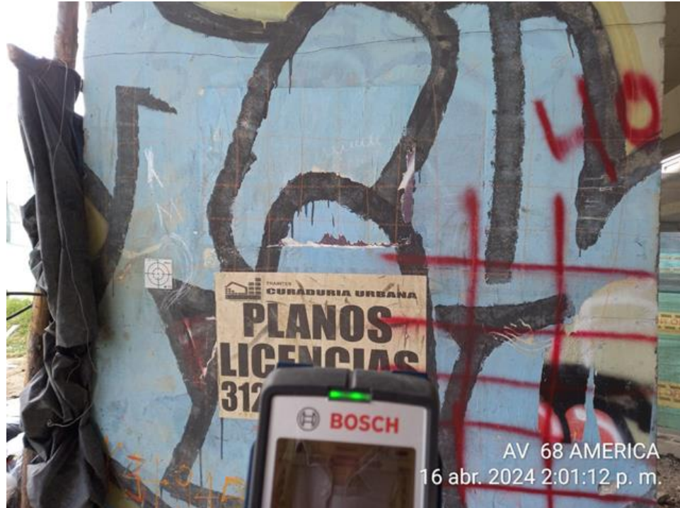
Figura 37: Escáner de refuerzo en Columna 4 – Eje 5, costado sur
