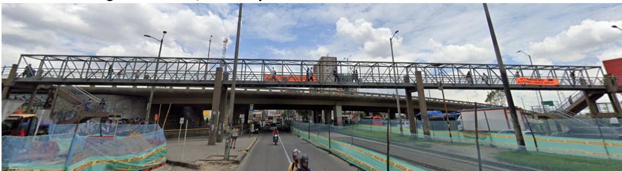
Figura 23: ID 3, Puente peatonal - Costado norte cruce Av-68.
