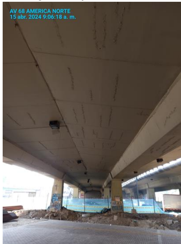
Figura 28: Inyección de fisuras
