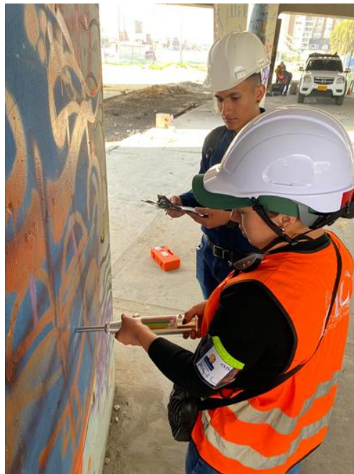
Figura 56: Esclerometría Columna 2 – Eje 3
