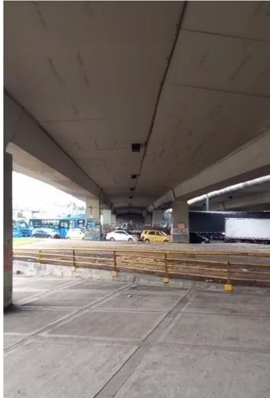
Figura 5: Fotografía zona inferior de puente Av. Américas con Av. 68
