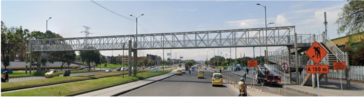
Figura 27: ID 7, Puente peatonal costado Occidental.
