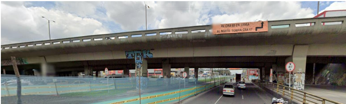
Figura 22: ID 2, Puente vehicular sur.
