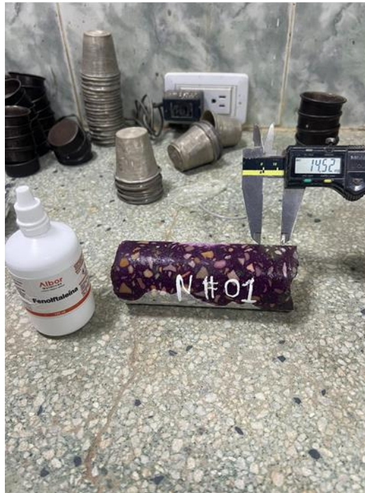
Figura 58: Carbonatación Núcleo Columna 4 – Eje 3, Costado Sur
