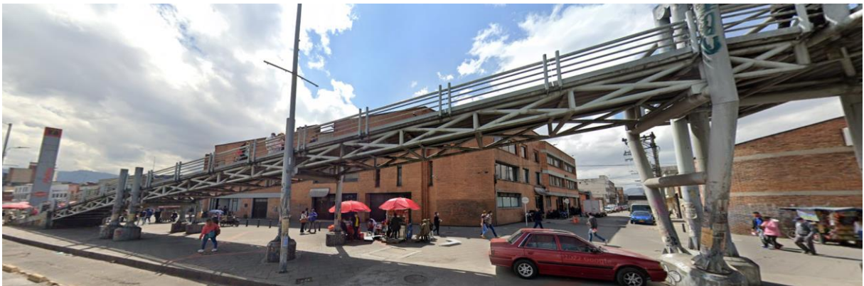
Figura 25: ID 5, Puente peatonal (Rampas) acceso estación Pradera
