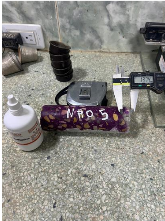
Figura 62: Carbonatación Núcleo Columna 3 – Eje 6, Costado Sur
