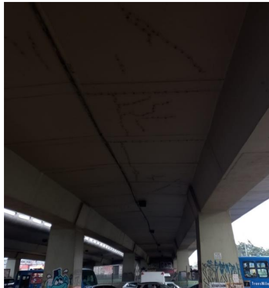
Figura 7: Fotografía zona inferior de puente Av. Américas con Av. 68
