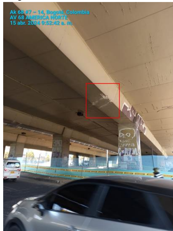
Figura 34: Pérdida de fibras de carbono
