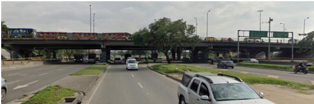
Figura 2: ID 1, Puente Vehicular Costado Norte
