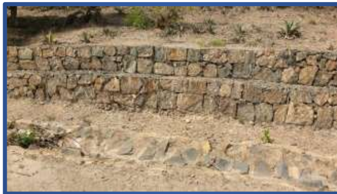
ILUSTRACIÓN 11 B) MUROS DE CONTENCIÓN
