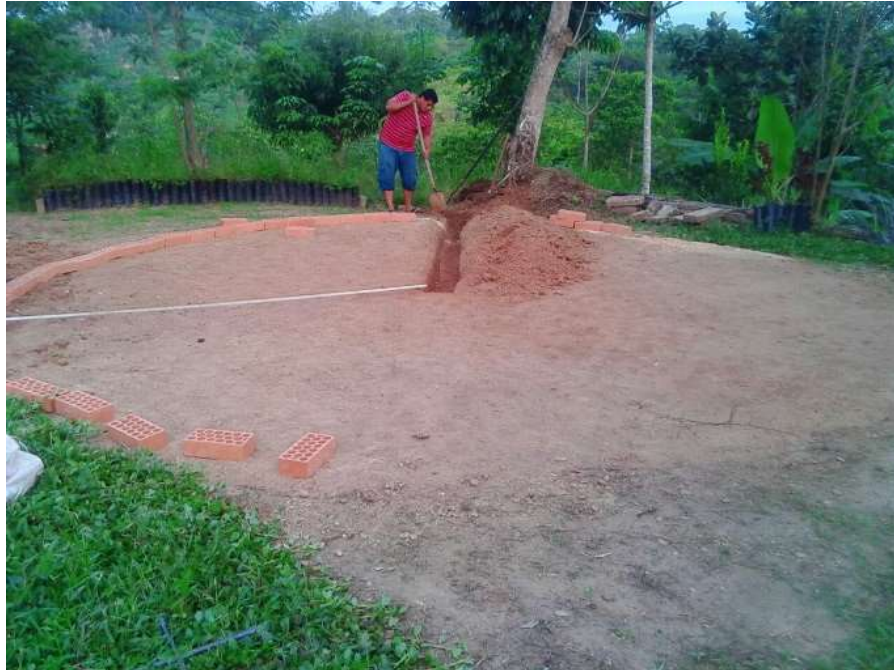
Replanteo y adecuación de terreno donde se pretende construir el reservorio FUNTE: Autor.
