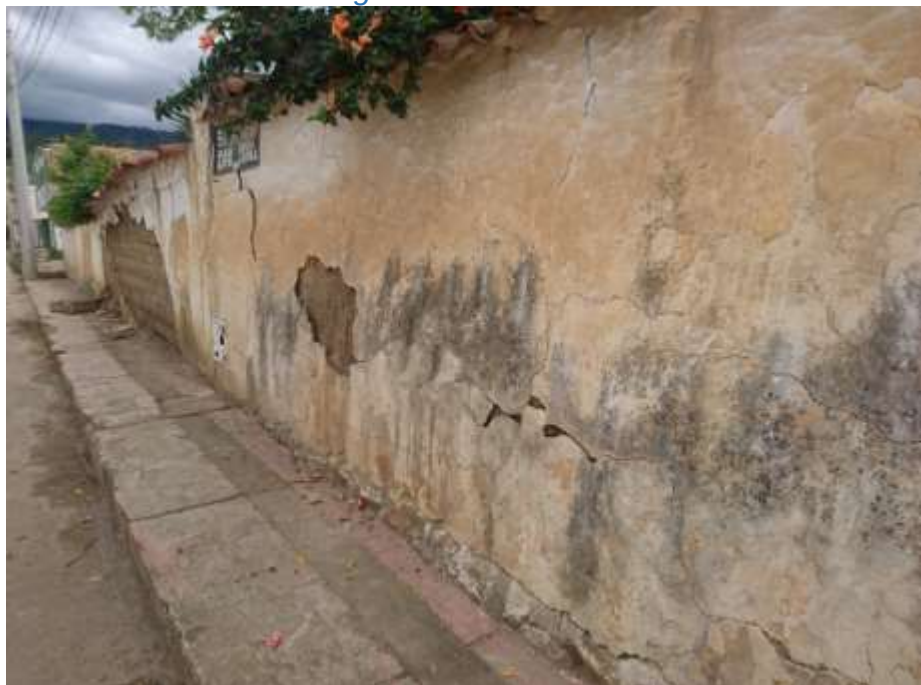
En la imagen 5. Vista frontal del muro. FUENTE: autor
