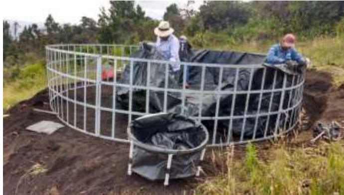
Construcción de reservorios
