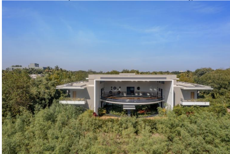
Figura 6. Fotografía fachada de un bloque del centro de bienestar Raga.
