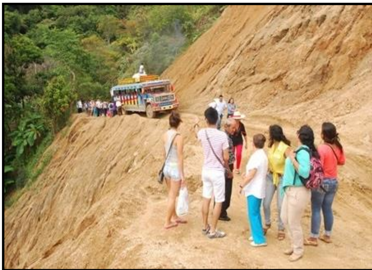
Foto No. 5 Mal estado de la vía
