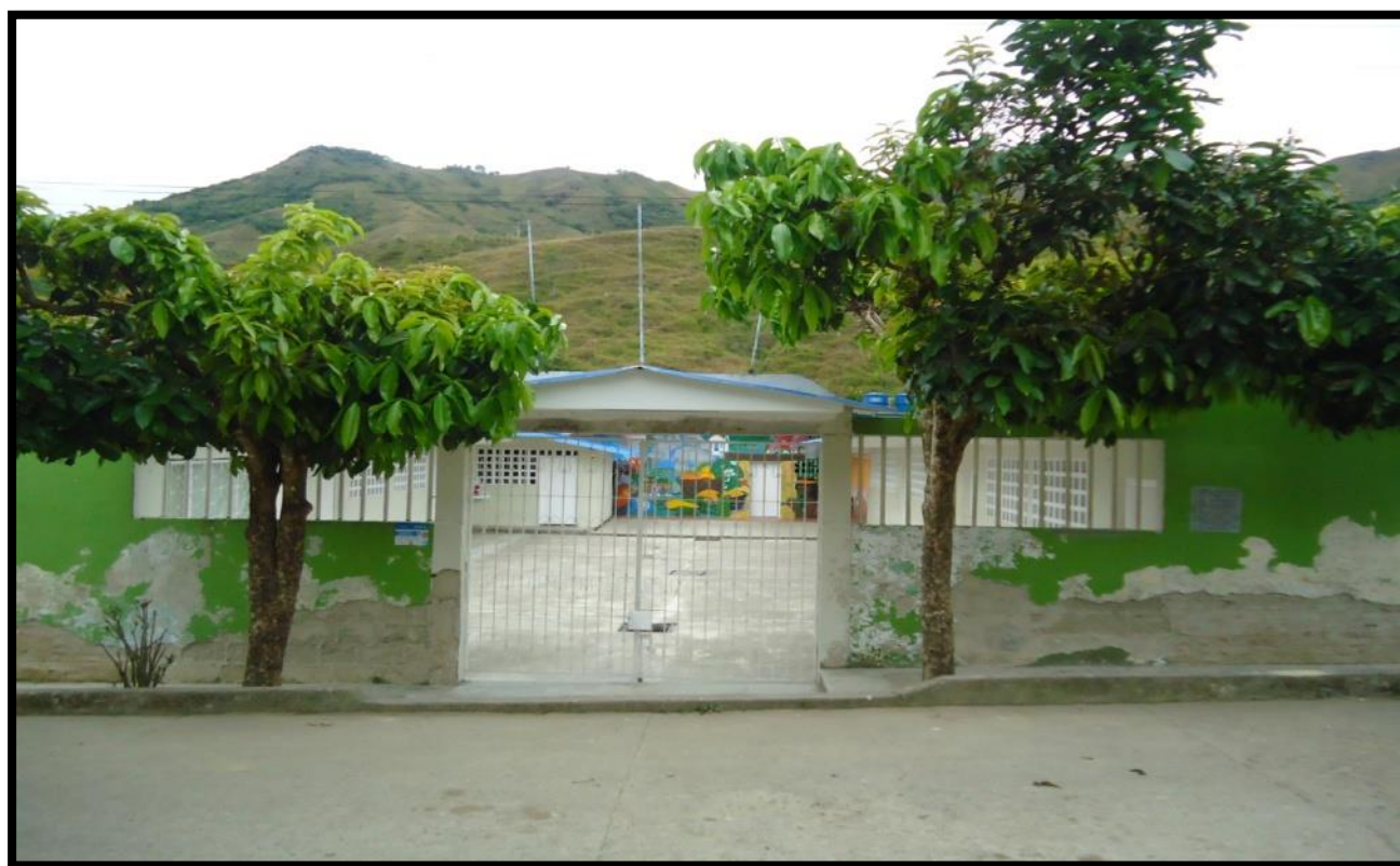
Foto 7: Fachada Sede Principal Institución Educativa San Luis Beltrán
