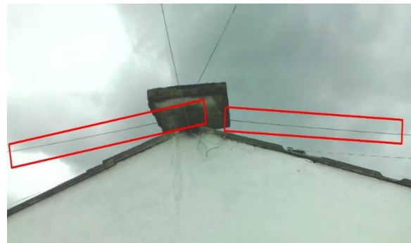
Ilustración 35. Cableado tirado por el aire2
