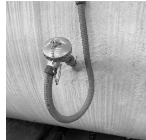
Figura 35. Sensor de temperatura PT100.
