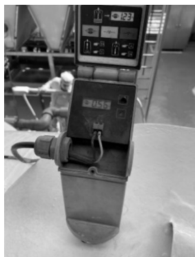
Figura 34. Sensor ultrasónico de nivel SIEMENS.
