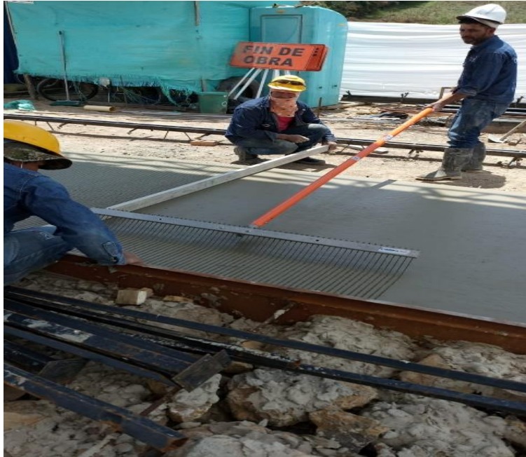
Figura 12: Texturizado del concreto
