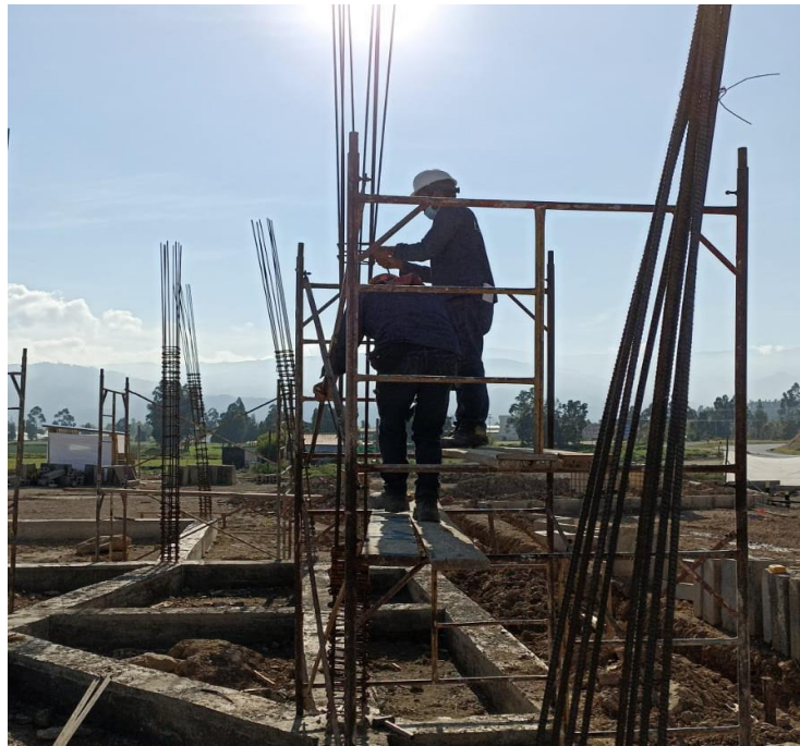
Figura 23: Amarre de acero de columnas
