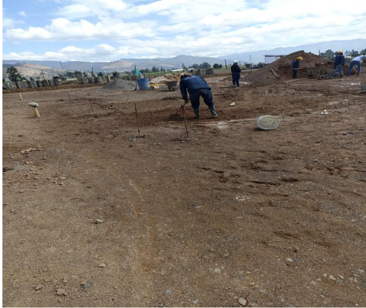
Figura 3: Nivelado de base
