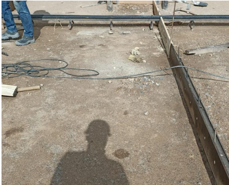
Figura 4: Instalación de formaleta
