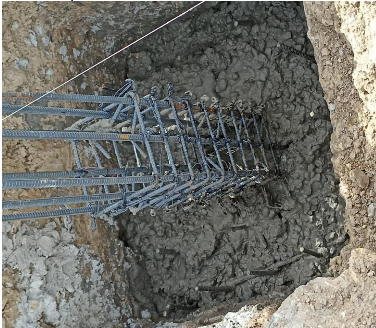
Figura 20: Fundición de zapatas
