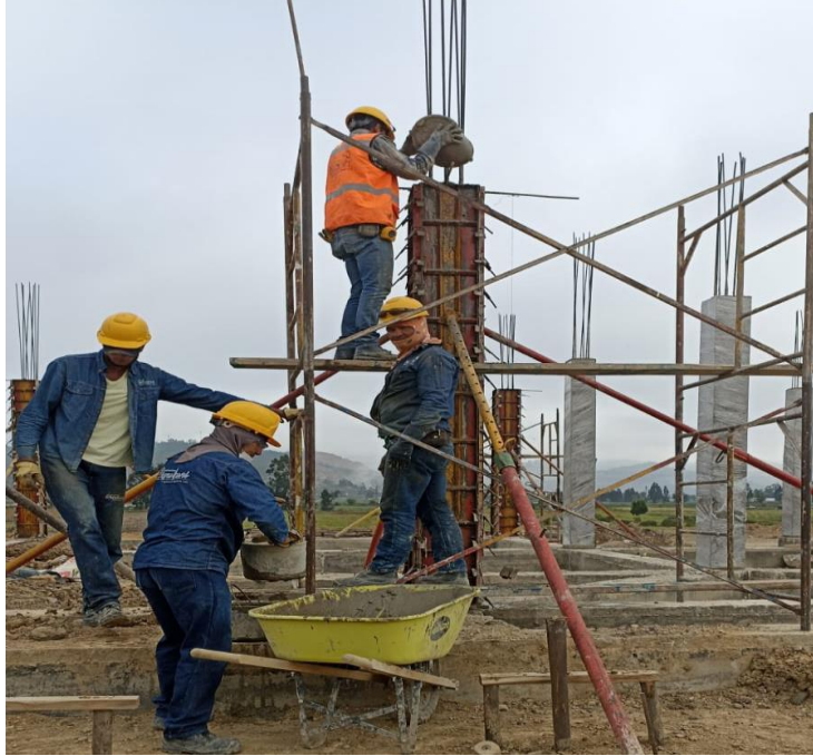
Figura 24: Vertimiento de concreto en columnas
