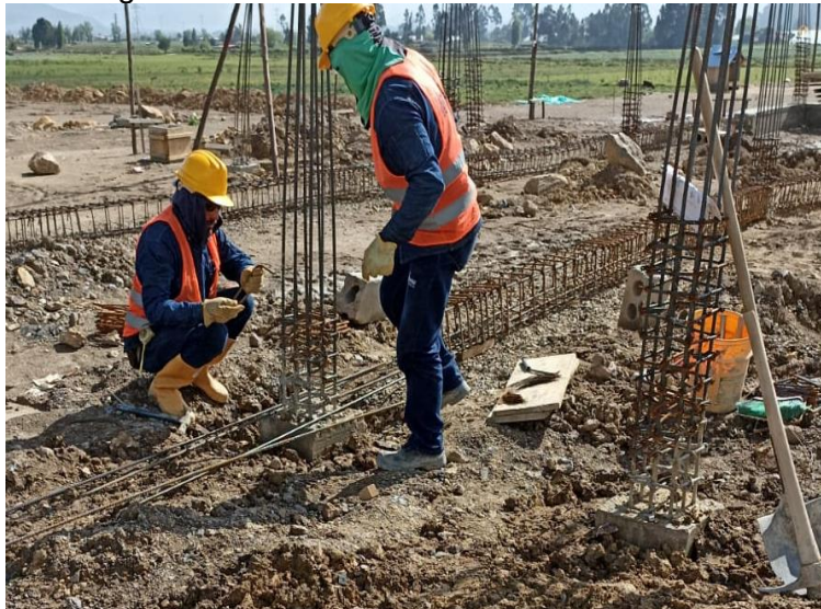
Figura 21: Armado de vigas de cimentación
