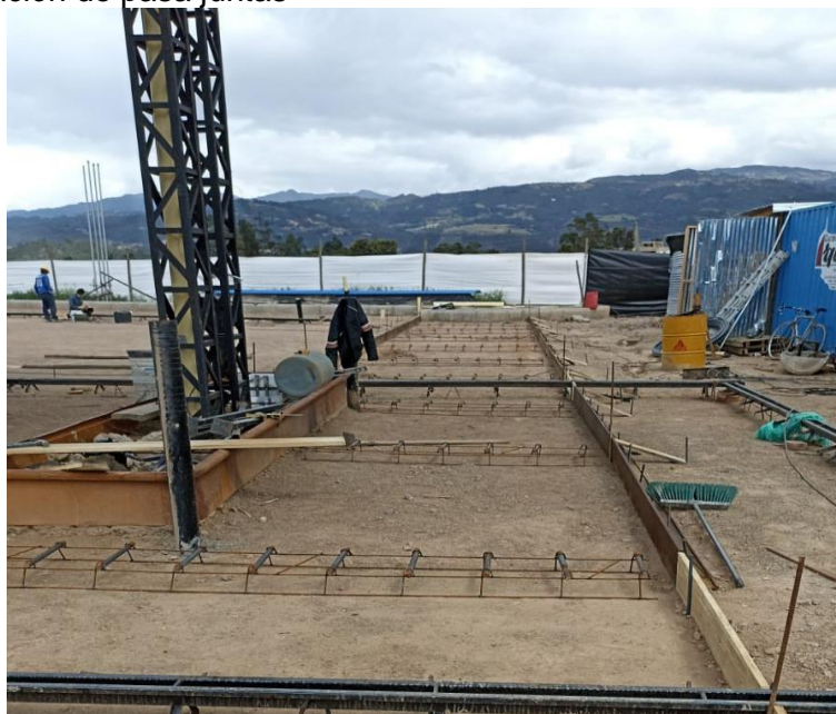
Figura 6: Instalación de pasa juntas
