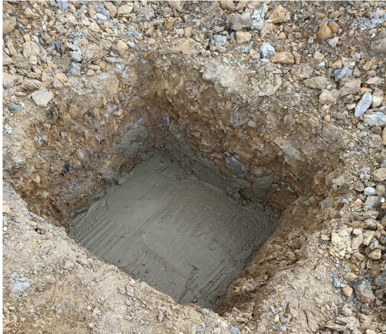
Figura 18: Solado de zapatas
