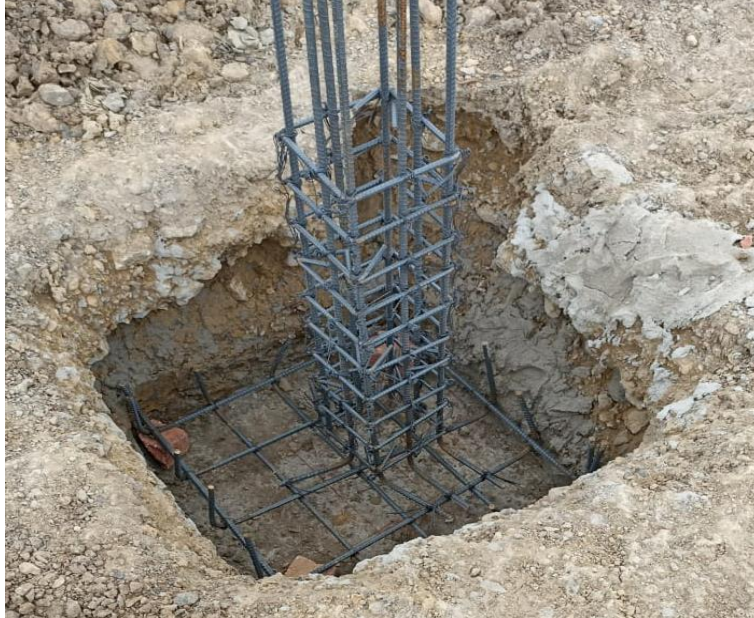
Figura 19: Parrilla de zapatas y pedestales
