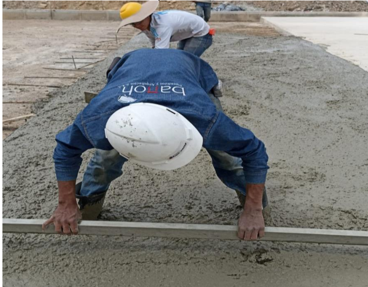
Figura 10: Nivelado del concreto con boquillera
