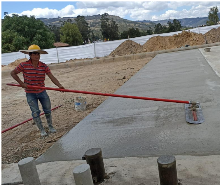
Figura 11: Alisado del concreto
