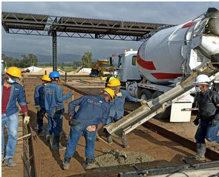
Figura 8: Vertimiento de concreto
