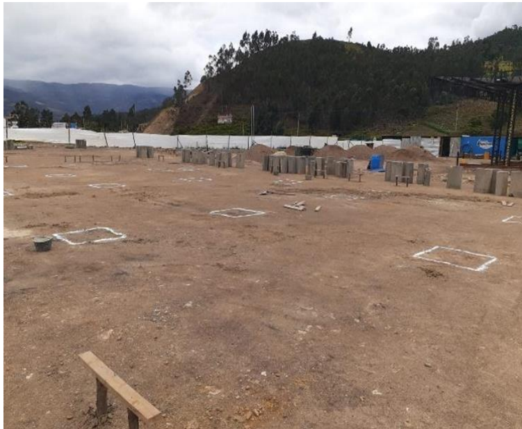
Figura 17: Replanteo de la zona de conveniencia
