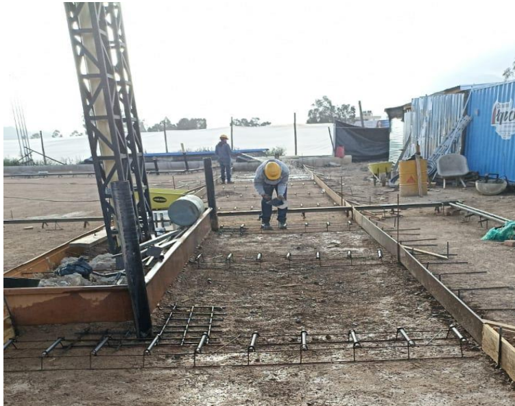
Figura 7: Preparación de la base
