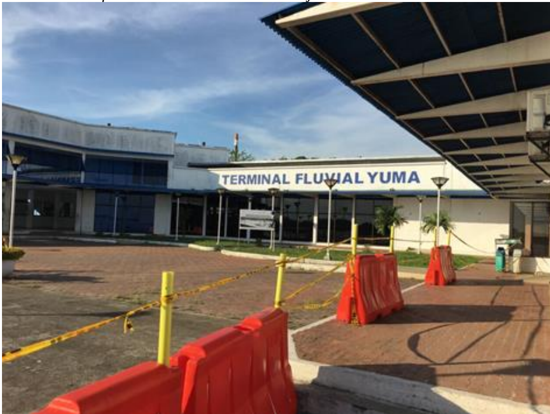
Figure 64. Terminal fluvial Yuma de Barrancabermeja.
