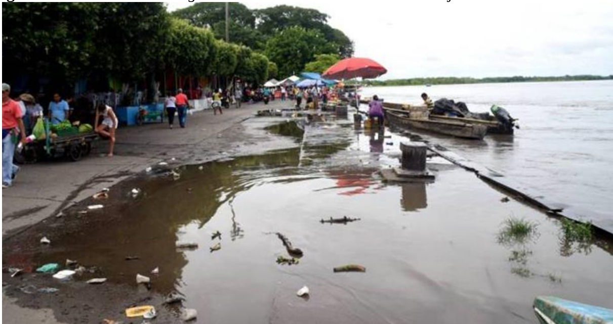
Figure 41. Erosión del río Magdalena en el muelle de Barrancabermeja.
