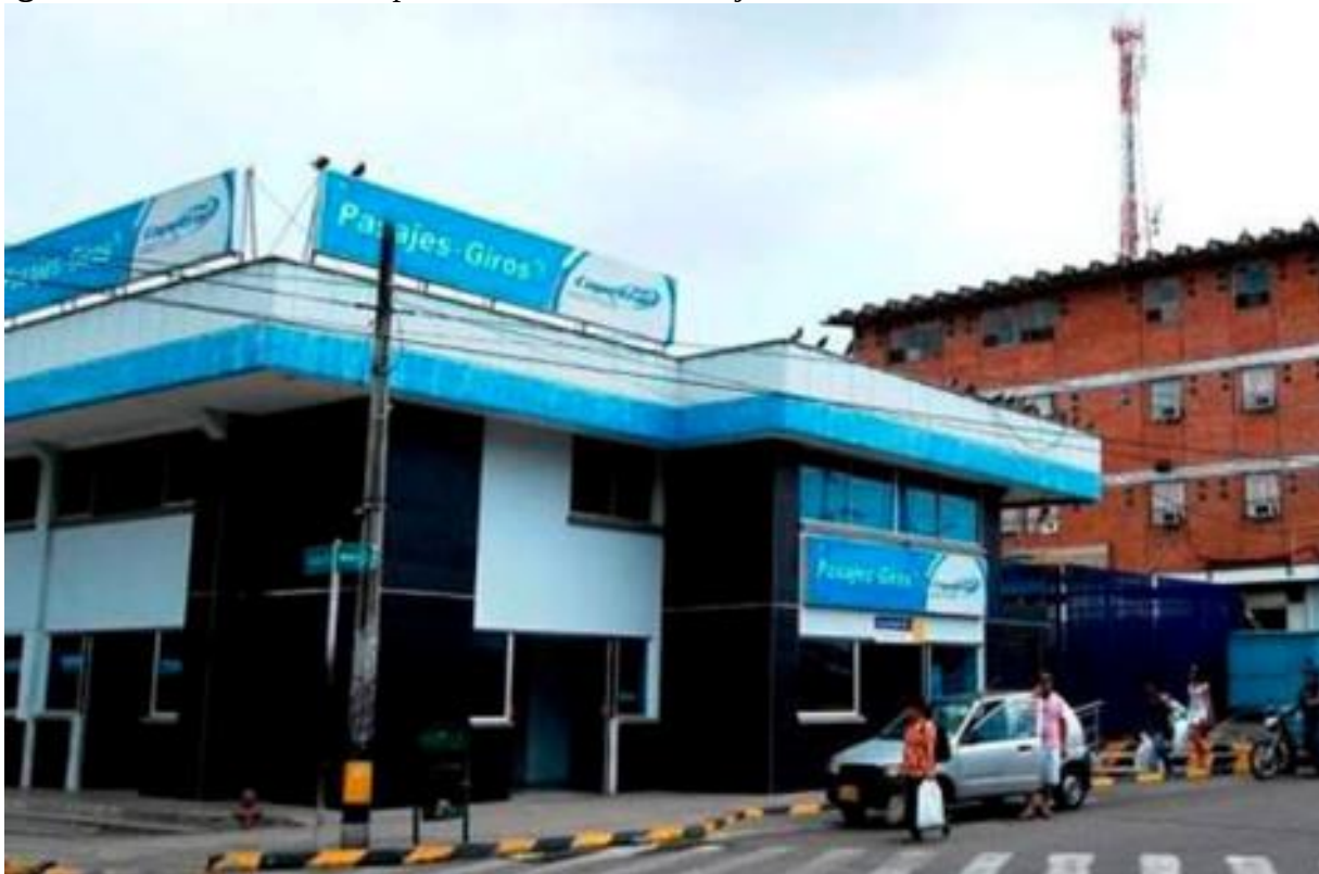
Figure 65. Terminal de transporte de Barrancabermeja.
