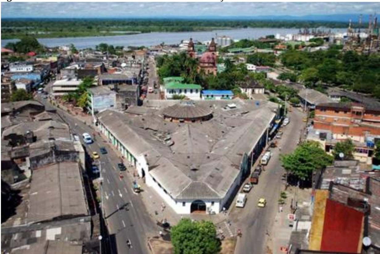
Figure 60. Plaza de mercado central de Barrancabermeja.
