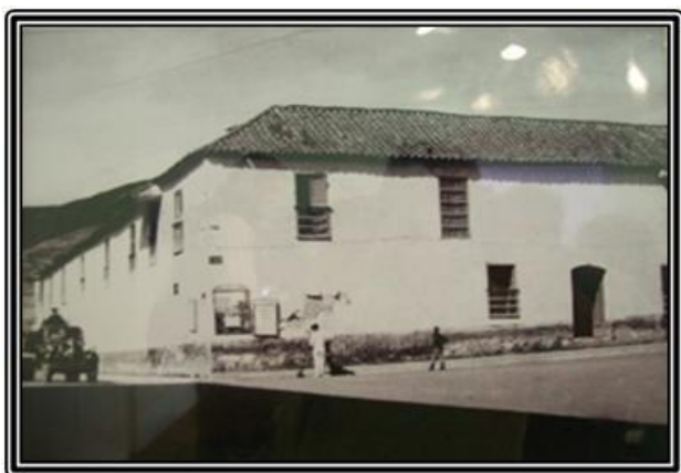
Figura 12. Esquina Calle real
