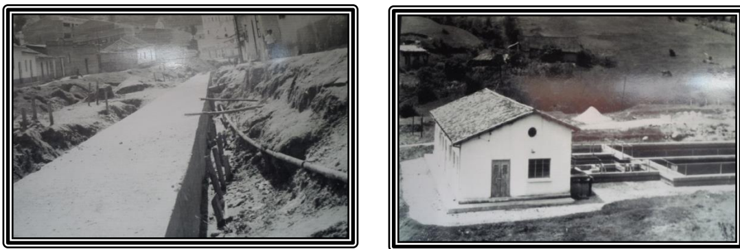
Figura 21. Construcción de Acueducto Pamplona y Los Tanques
