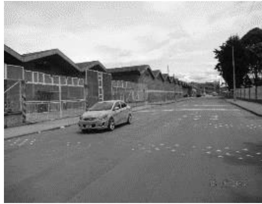
Figura 7 Fachada Norte_Calle 9 Fuente: Autor
