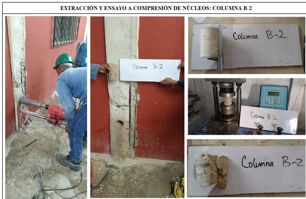
Figura 19. Extracción de núcleo en columna B-2.
