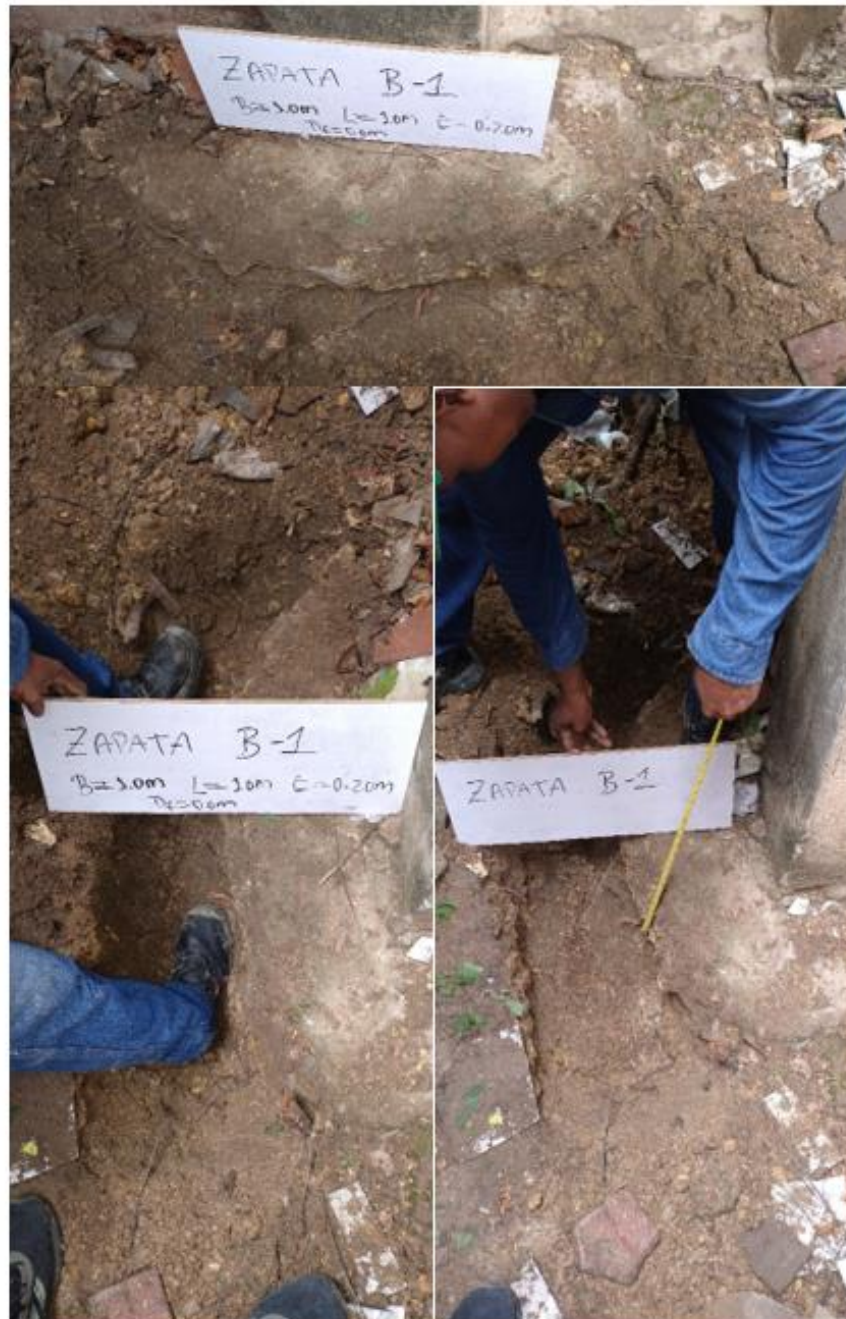
Figura 30. Inspección de cimientos.
