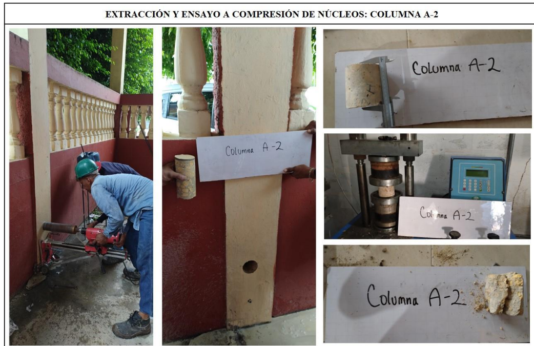
Figura 18. Extracción de núcleo en columna A-2.
