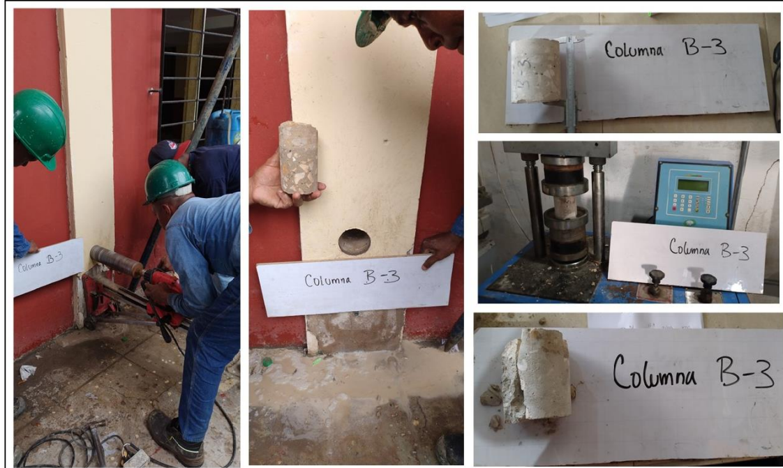
Figura 23. Extracción de núcleo en columna B-3.
