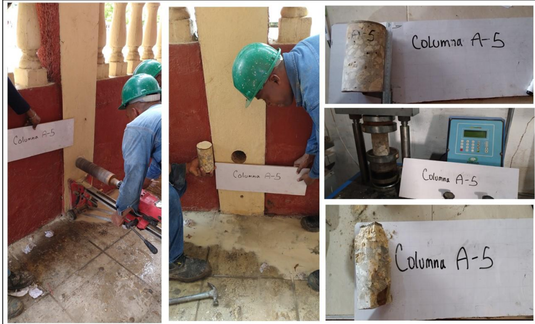
Figura 22. Extracción de núcleo en columna A-5.
