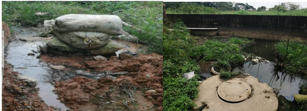
Fotografía 11. Contaminación por agua residual y presencia de residuos sólidos. Por Diego Torres; Diana Güiza, 2019.
