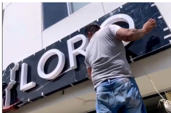
Figura 17. Proceso de adecuación punto físico LORO foto 2
