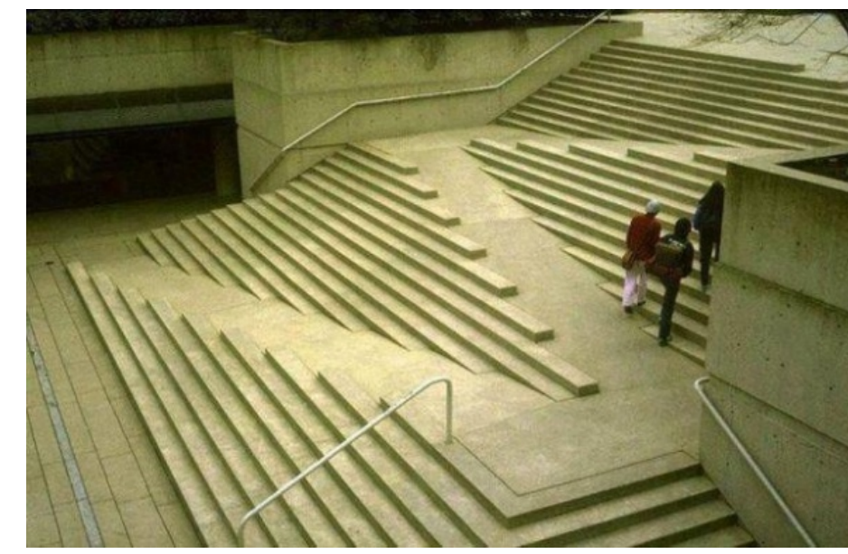
RAMPA Y ESCALERA
