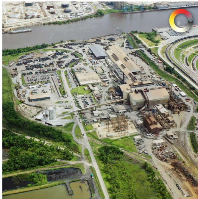
Figura 2. Vista desde dron de la planta ubicada en Vidor, TX
