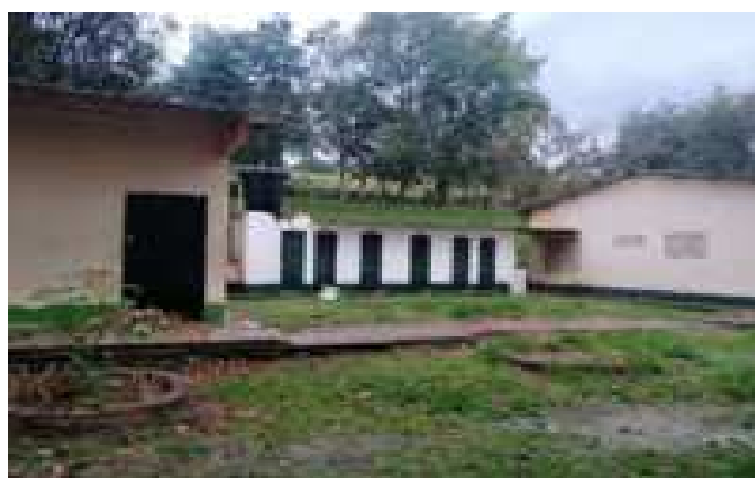
Figura 9. Baños antiguos Escuela Jordán
