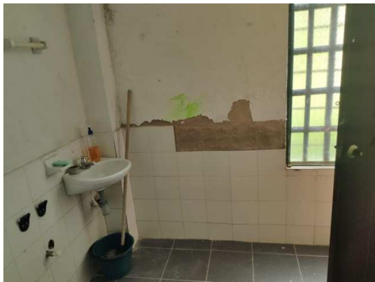
Figura 16. Aula de Galería con presencia de Humedad
